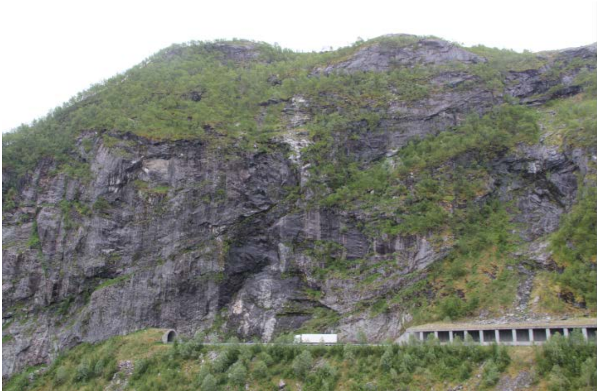
Svartholla tunnelinnslag og skredoverbygg (Foto: Ole-André Helgaas, SVV)
