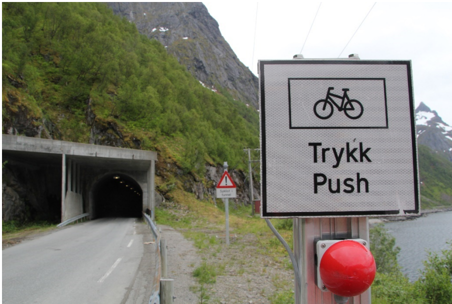
Varslingsanlegg for sykkel ved Breitindtunnelen (Foto: Ole-André Helgaas, SVV)
