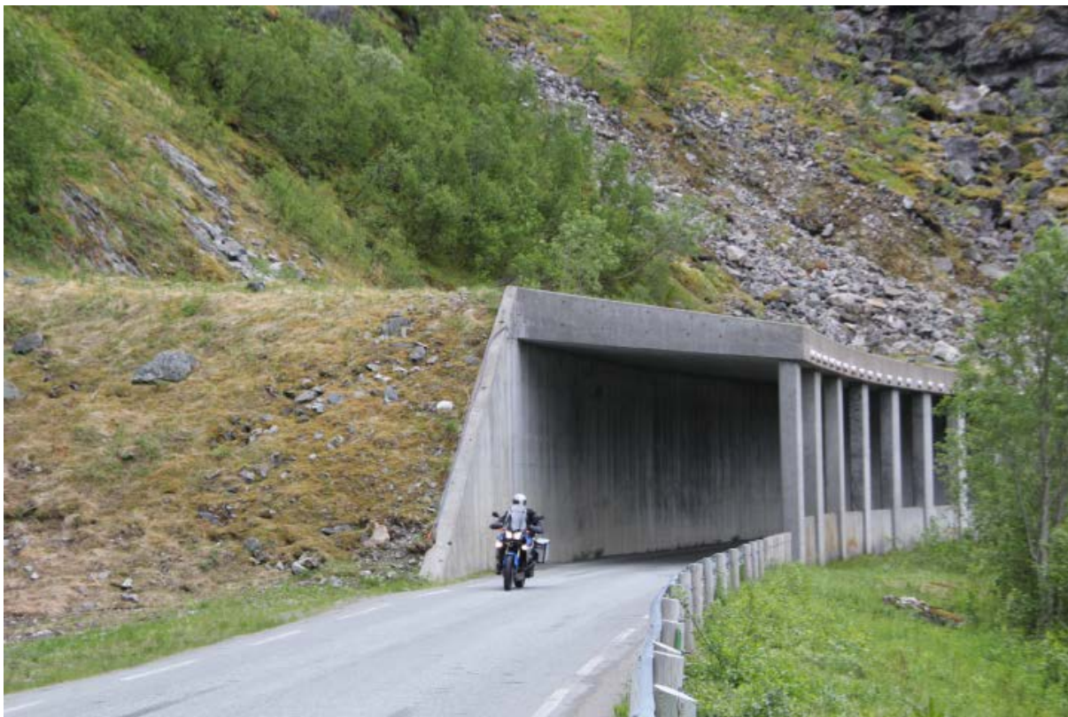
Svartholla skredoverbygg (Foto: Ole-André Helgaas, SVV)
