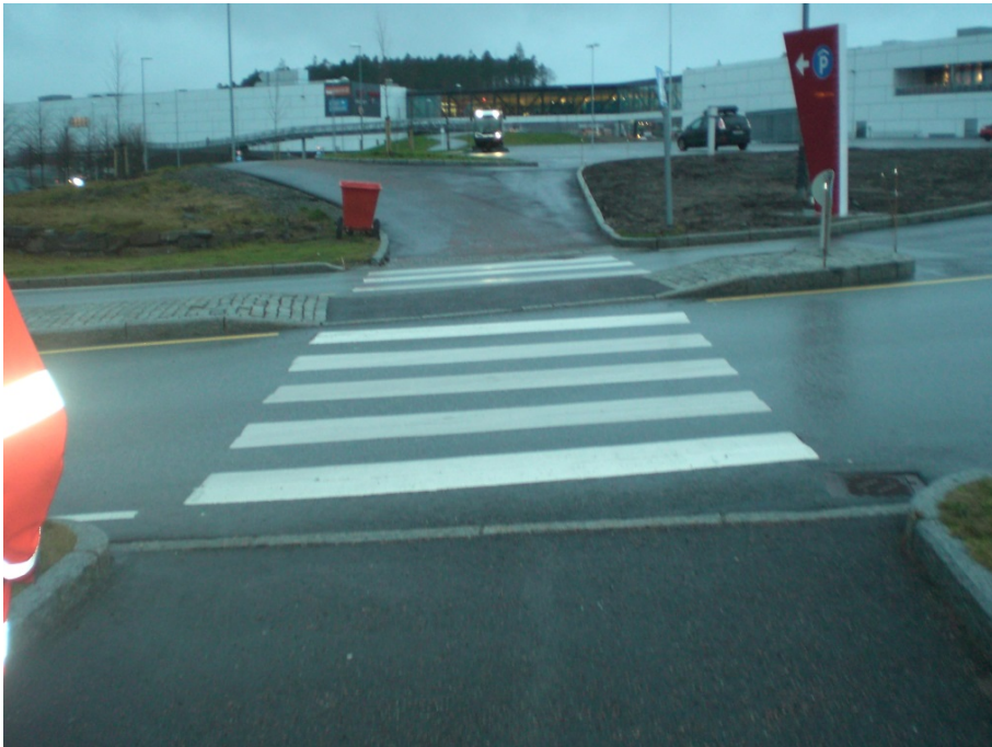
Tilrettelagt krysningspunkt. Mangler varselindikator på den ene siden.
