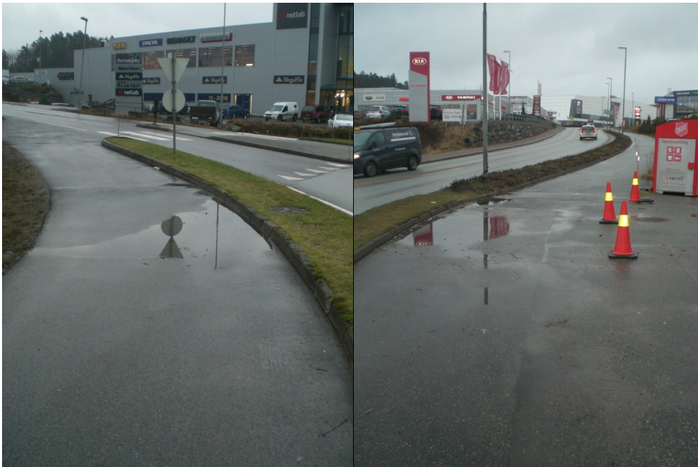
Vannproblematikk i gang- og sykkel feltet. Bildet til høyre har i tillegg ingen grenser som skiller parkeringsarealet og gangfeltet med unntak av de oppsatte kjeglene.
