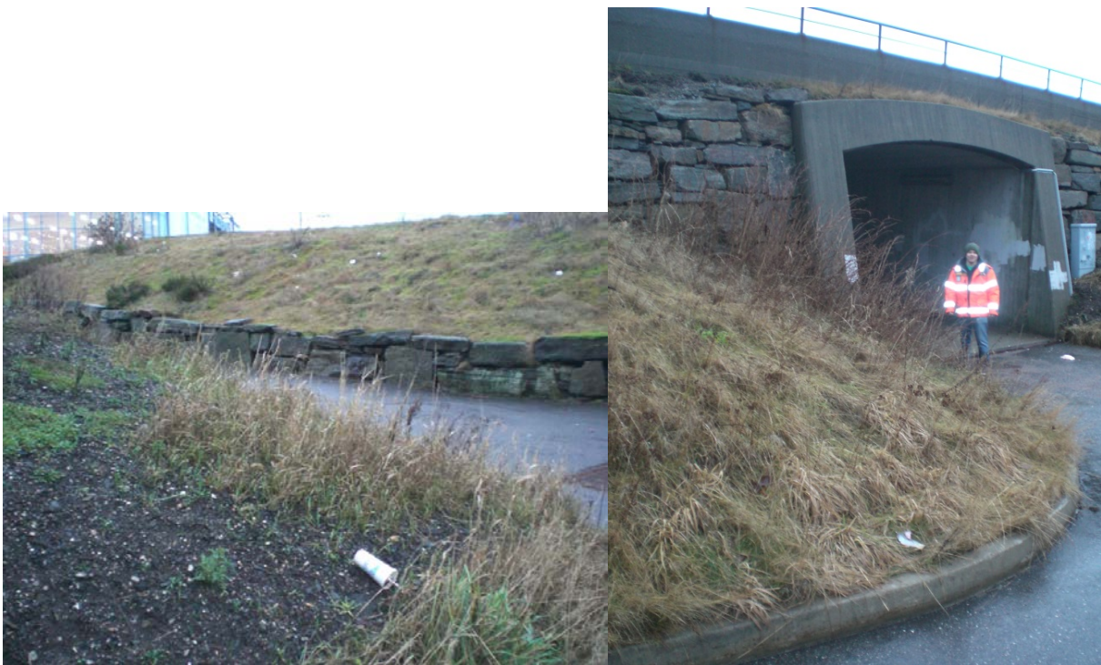
Sikt inn og ut av kulvert.
