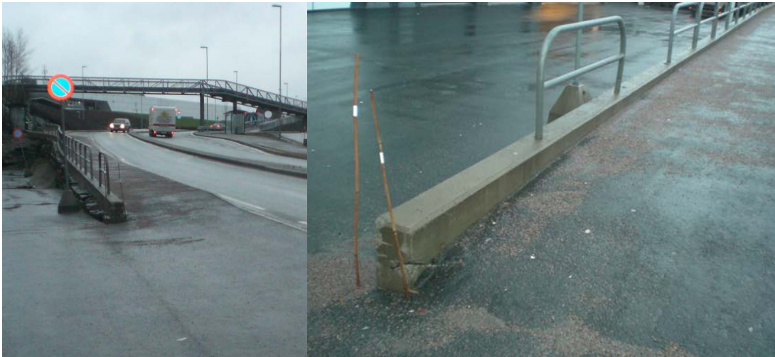
Gjerde for å sikre myke trafikanter mot bratt skråning. Den butte enden er lett å hekte pløgen i.
