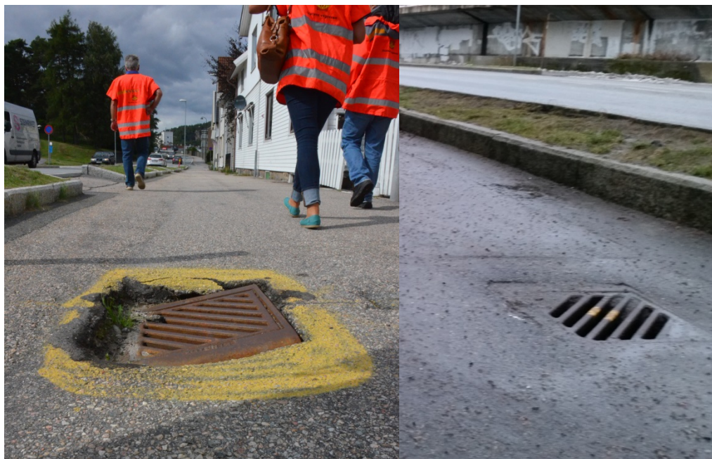
Flere av ristene langs strekket har fått en overhaling.
