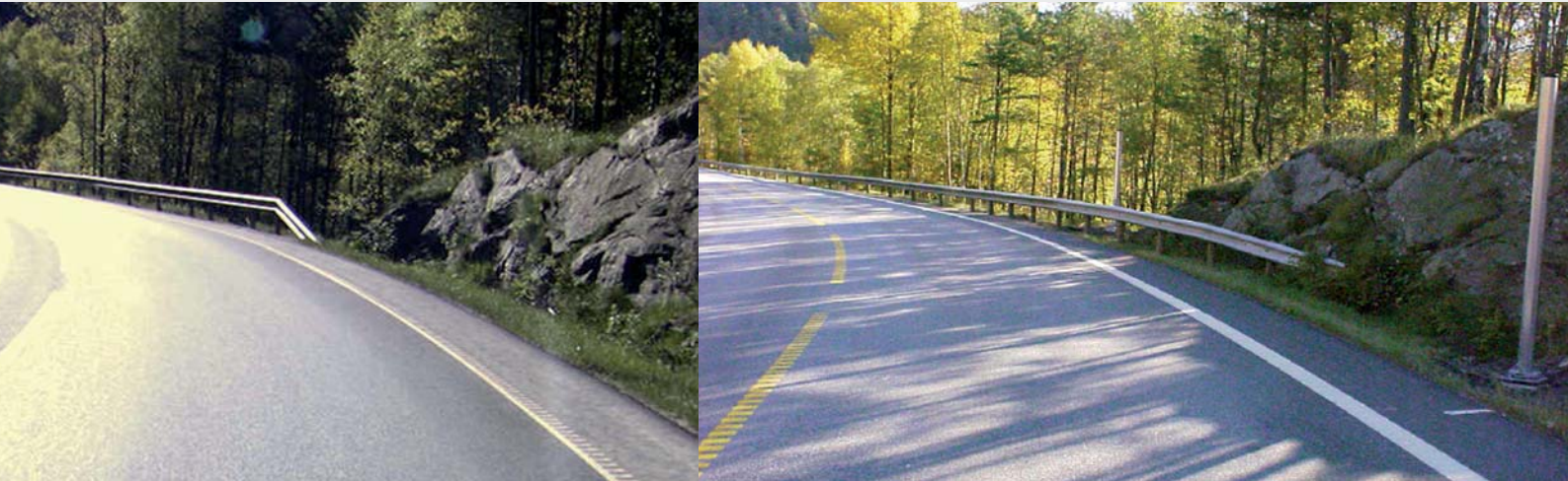
Eksempler på rekkverksavslutning før og etter utbedring
