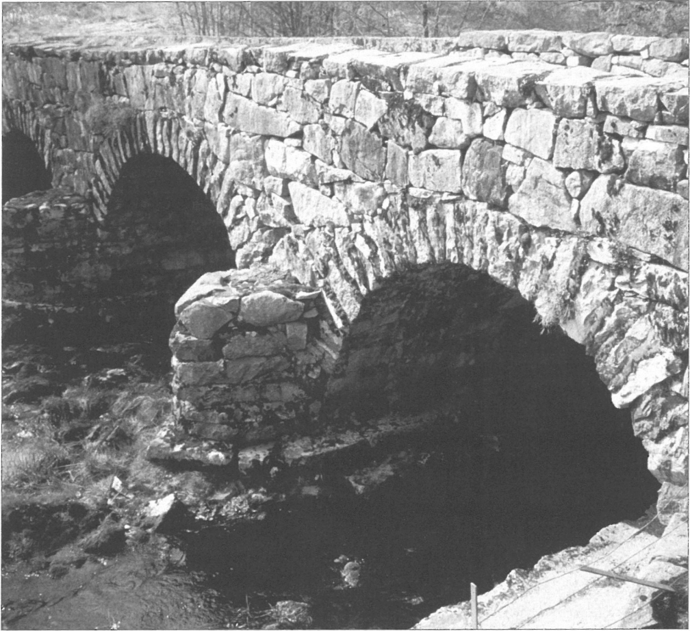
Sokkatjønn bru fra 1842, i Eigersund kommune. Bygd som del av den Vestlandske Hovedvegen, ny bru overtok i 1957. Foto: Torstein Rein-Larsen.
