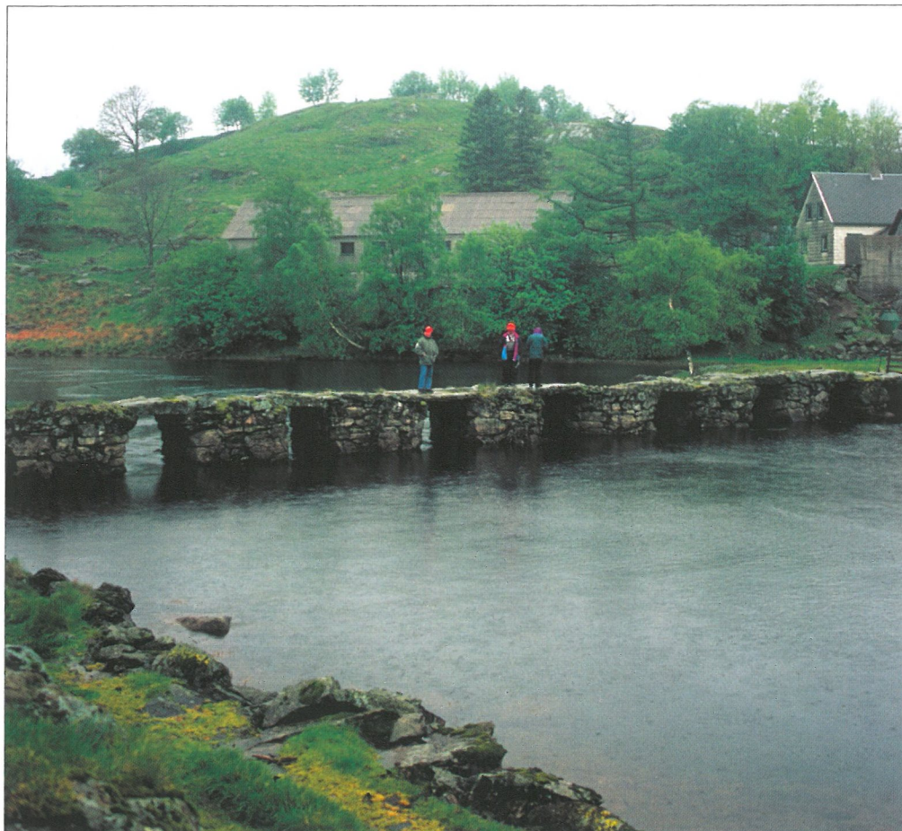
Barstad bru fra ca. 1850, i Sokndal kommune. Foto: Torstein Rein-Larsen.
