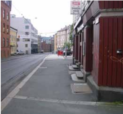
Pilestredet, Oslo. En vanlig situasjon med trappeutspring og lave kanter inne ved veggen som kan gi snublefare. Her burde det ha vært en veggsoner. Vannrennen i forgrunnen er et eksempel på en løsning som er lett å passere med rullestol og rullator.
