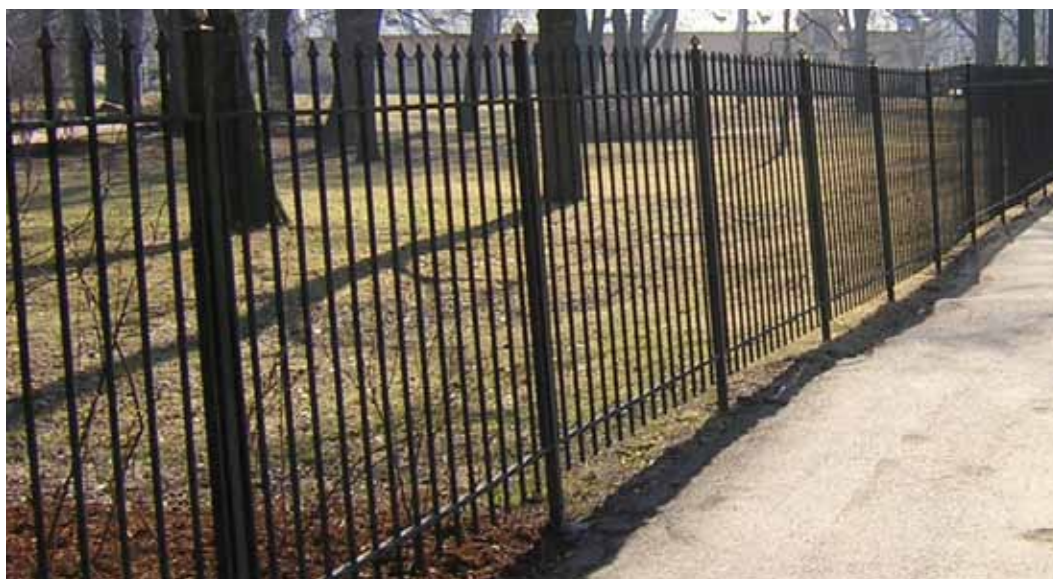
Slottsparken, Oslo. Gjerdet fungerer godt som ledende element fordi det ligger tett inntil gangveien og dermed kan følges med hånden eller stokken. Foto: Elin Katrine Nilsen.
