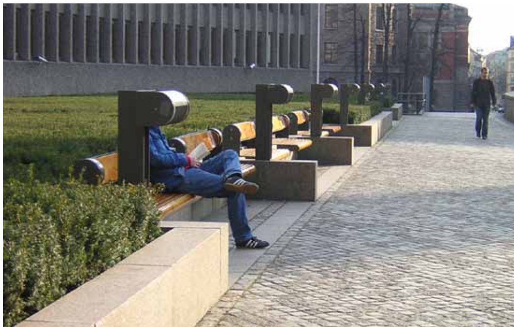
Akersgata, Oslo. Her er benkene trukket fint ut av gangarealet, men materialbruken er gjort omvendt, ved at det er glatt dekke under benkene, og gatestein i gangarealet. Dette gir ujevn gå/kjøreflate. Det er også egen belysning til benkene. Foto: Elin Katrine Nilsen.
