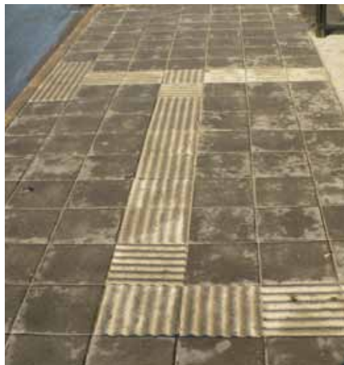
Porsgrunn. Detalj av ledelinjer og belegg på holdeplass. Kontrasten mellom ledelinjene og de andre hellene burde ha vært større og oppmerksomhetsfeltet dypere. Foto: Ragnar Grøsfjeld.
