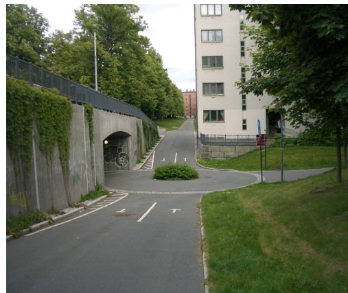
Chr. Michelsens gate, Oslo. Bred undergang med rundkjøring og adskilte kjøreretninger for syklistene. I selve undergangen er arealet for fotgjengere og syklistene adskilt. Foto: Finn Aslaksen.
