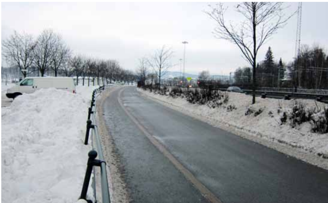
Frognerstranda. Sykkelveg med fortau. Gående og syklende er fysisk adskilt med kantstein og høydeforskjell. Fortau til venstre i bildet. Foto: Finn Aslaksen.
