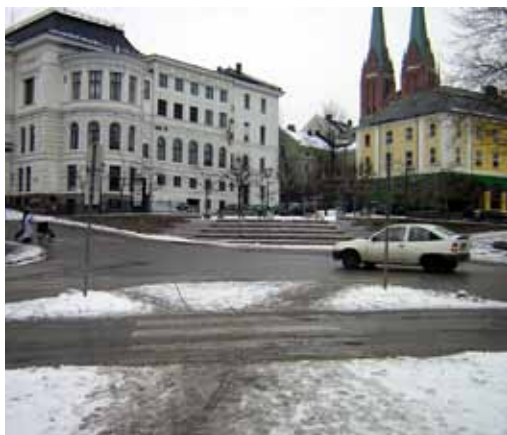
Skien sentrum. Kryss med fotgjengeroverganger i spesielle vink-ler, gir store utfordringer for synshemmede. Det er lett å havne midt ute i krysset, når ikke trafikkøyer er markert og rekkverk/ledegjerde mangler.
