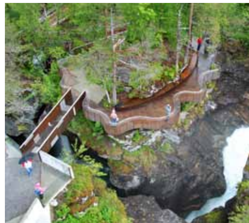
Utsiktspunkt for alle. Nasjonal Turistveg ved Gudbrandsjuvet i Valldalen. Trinnfri atkomst og rekkverk som kan fungere som naturlig ledelinje. Foto: Magne Flemsæter/Statens vegvesen.
