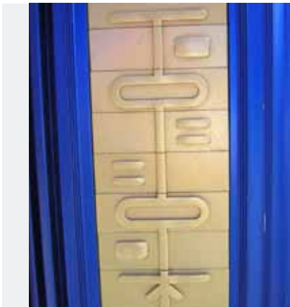
Oslo, Stortingsgata. Taktill angivelse av gatekryssing på boksen på signalanlegget. Foto: Elin Katrine Nilsen.
