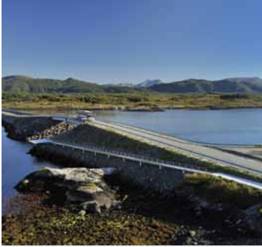
Fiskeplass for alle! Nasjonal Turistveg, Atlanterhavsvegen, Averøy. Rampe med slak stigning legger til rette for at flere kan bruke fiskeplassen under brua. Foto: Jarle Wæhler/Statens vegvesen.
