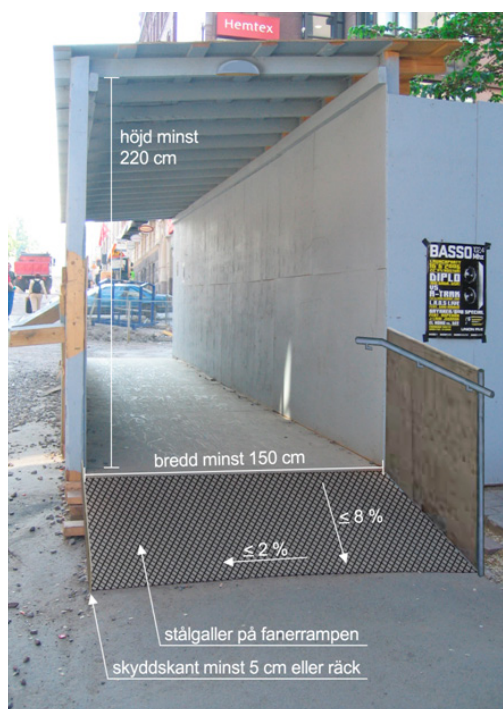
Helsingfors kommune. Eksempel på informasjon om krav ved anleggsarbeid. Foto: Helsingfors kommune.
