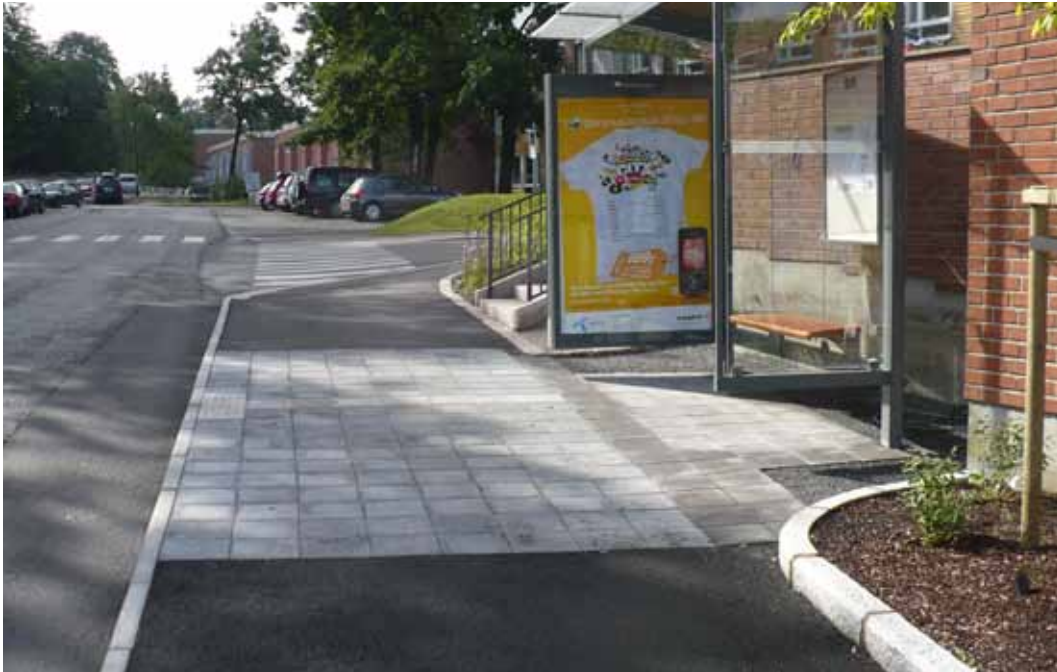
Holdeplass ved Porsgrunn sykehus. Holdeplassen er lett å finne og den er lett å se for de kjørende. Det er gode naturlige ledelinjer fram til holdeplassen. På selve holdeplassen er det i tillegg kunstige ledelinjer, men disse burde ha hatt større kontrast i forhold til de andre hellene på selve holdeplassen. Foto: Ragnar Grøsfjeld.
