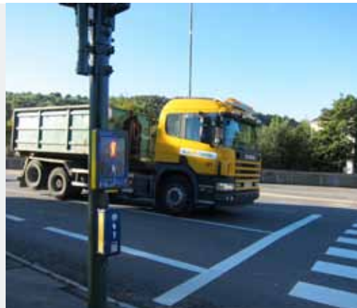
Oslo, Bispegata. Signalanlegg med signal på samme side som man venter (PUFFIN-anlegg). Foto: Finn Aslaksen.
