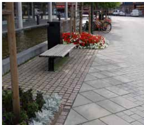
Bratsberg brygge, Porsgrunn. Eksempel på en møbleringssone, hvor benker, trær, sykkelstativer og søppelkasser er samlet i en stripe ved siden av gangarealet. Her er det riktig materialbruk med gatestein i møbleringssonen og jevne heller i kombinasjon med låsestein i gangarealet.
