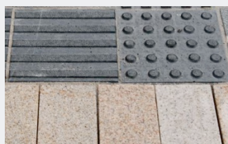
Eksempel på mørk kunstig ledelinje kombinert med lys naturstein. Kontrasten er K=0,35 og derfor innenfor håndbokas krav.
