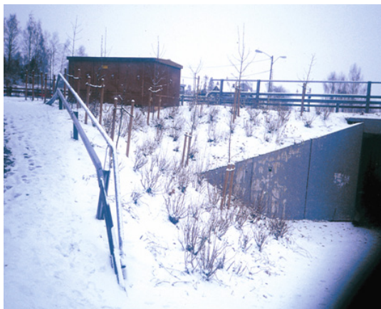
Hagan, Nittedal. Typisk undergang – for bratt for mange bevegelsehemmede. Foto: Finn Aslaksen.
