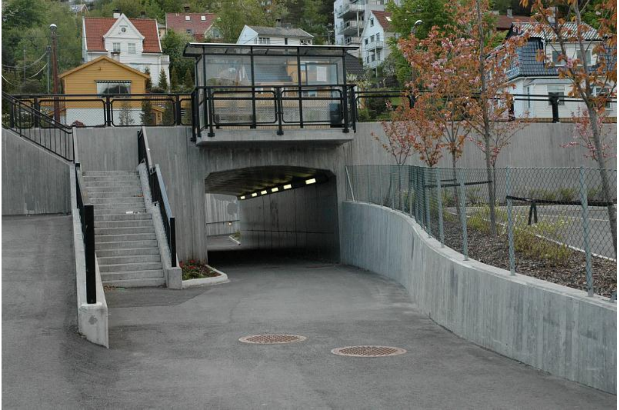
Figur 20: Undergang E39 Fjøsangerveien Foto: Cecilie Bakke Johannessen
