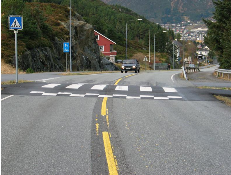
Figur 03: Opphøyd gangfelt merket opp med oppmerking 1027, i tillegg til oppmerking 1024. Foto: Statens vegvesen
