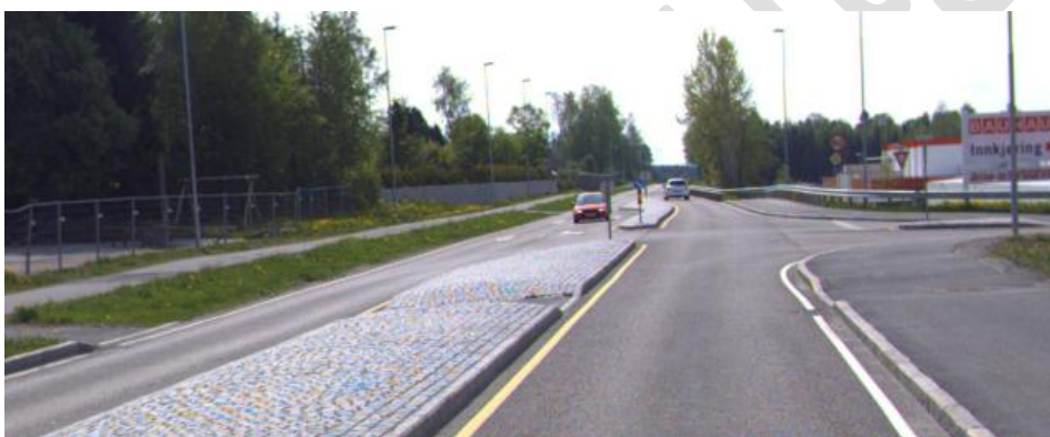
Figur 21: Tilrettelagt kryssing på Fv. 6 i Vestby kommune.
