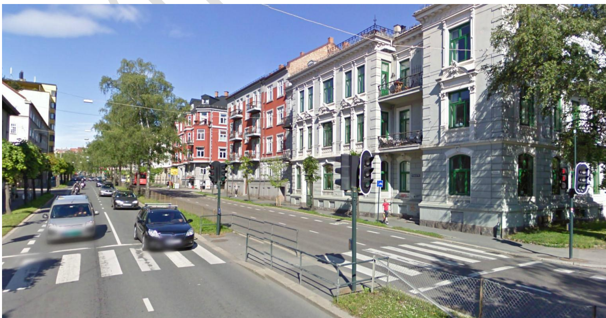
Figur 15. Saksing av gangfelt ved Kirkeveien i Oslo. Foto: Google
