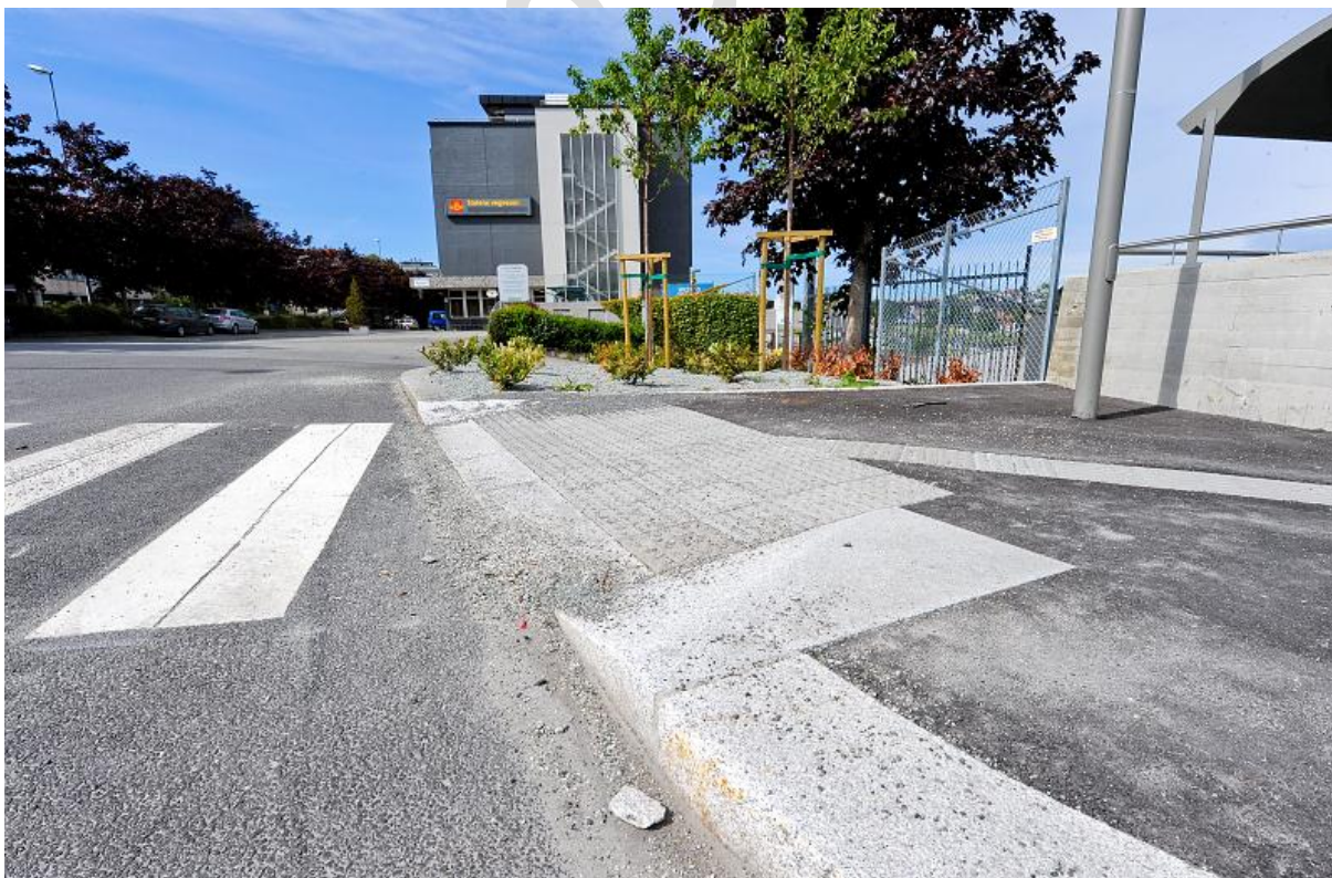
Figur 26. Nedsenket fortauskant ved gangfelt. Taktile / kunstige ledelinjer og oppmerksomhetsindikator. Ved Paradis stasjon i Stavanger. Foto: Knut Opeide.
