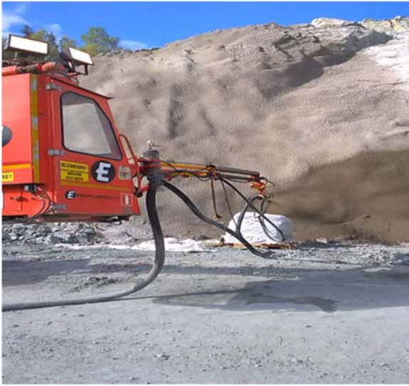
Sprøyting ved påhugg
