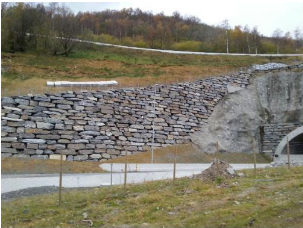
Figur 8 Mur med høyde inntil 12 m som avstiver terreng og øverst en fylkesveg. Muren står dels på berg og dels på løsmasser.
