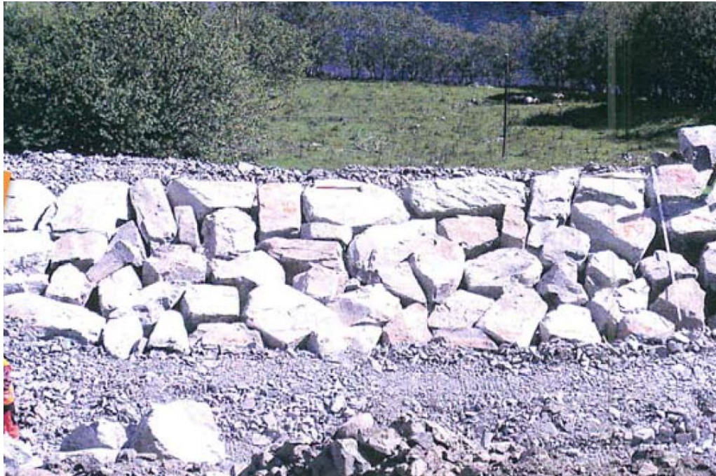
Figur 3 Eksempel på utlagt steinskiift i mur 12 med såkalt "mosaikkmonster". Her med relativt små muresteiner i forhold til overordnet forventning om å oppnå forbandeffekt. Avviket fra prosjekteringskravene er betydelig.
