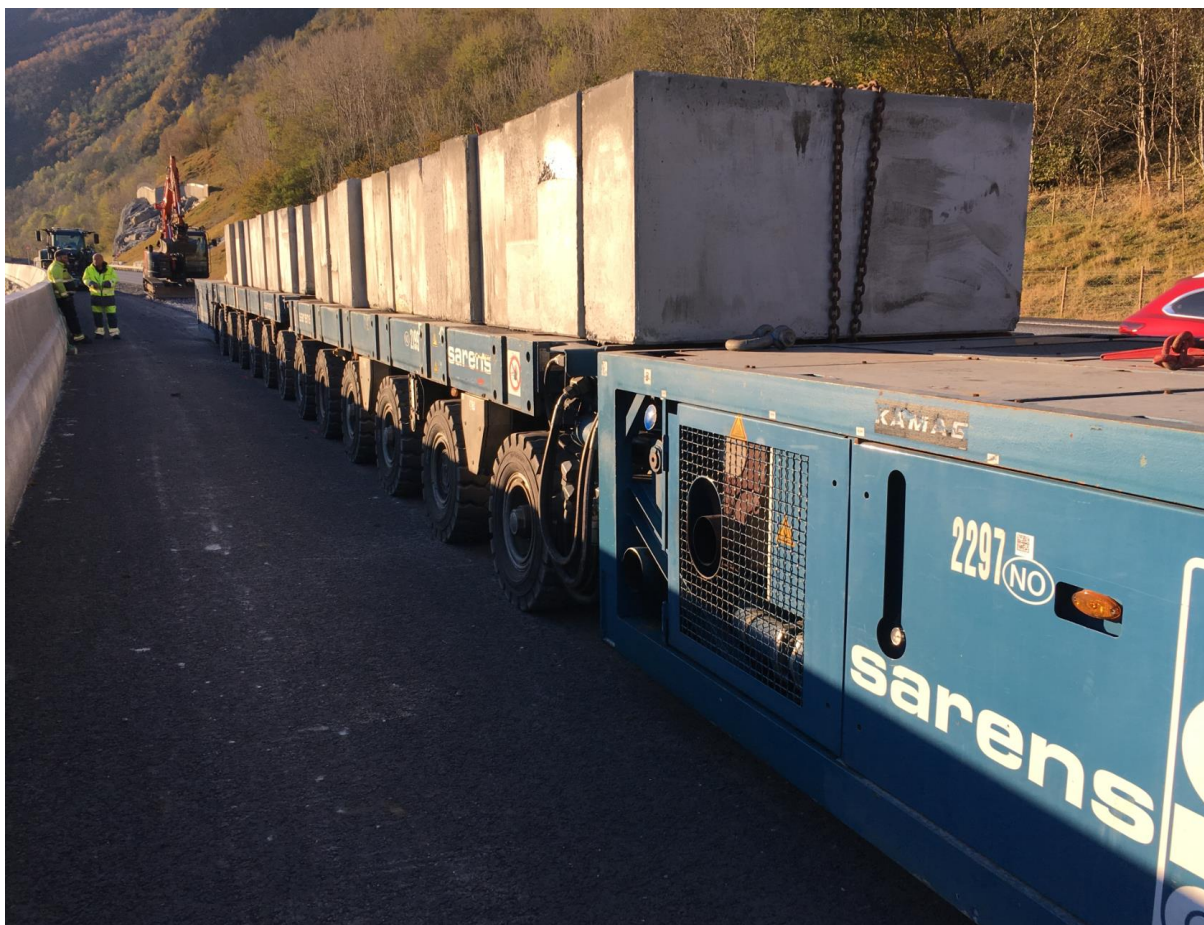
Figur 25 Prøvebelastningsrigg ved Mur 12. Yttergrense for last ca. 2,5 m innenfor ytterkant mur. Drensgrøft mellom GS-veg og veg gjenfylt med subbus.
