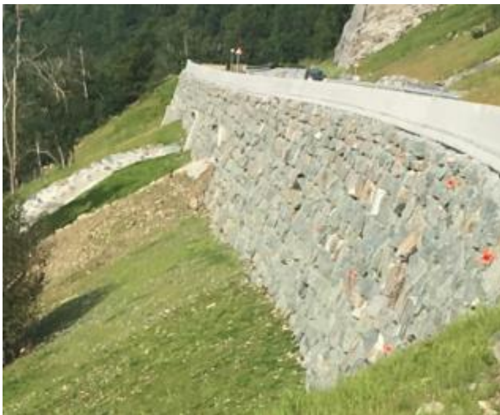
Figur 9 Mur 12 i Stordalen som bærer GS veg og kjørefelt med relativt sterkt fallende terreng på nedsiden.
