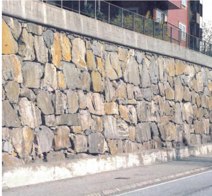
Figur 21 Eksempel på privat bygget tørrmur fra Voss, illustrert i Håndbok V270 Tørrmuring md maskin. Utstrakt bruk av kiler og mindre stein. Antatt for å oppnå planest mulig visflate. I prinsippet en usikkerhet mht hver enkelt murestein sin stabilitet.
