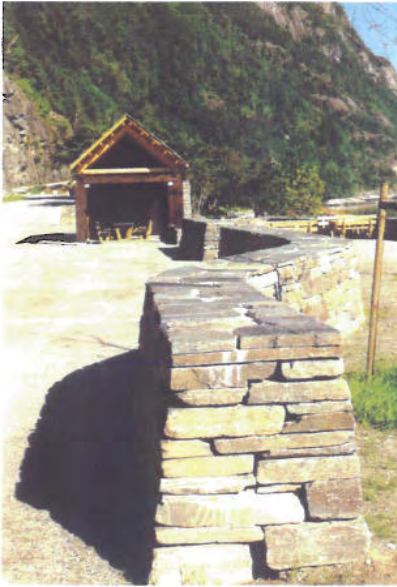
Steinstøberget, Rv 7 i Hordaland. En mur av naturstein er her benyttet for å skille rastedelen fra trafikkarealet. Foto: Unni Haugtun.
