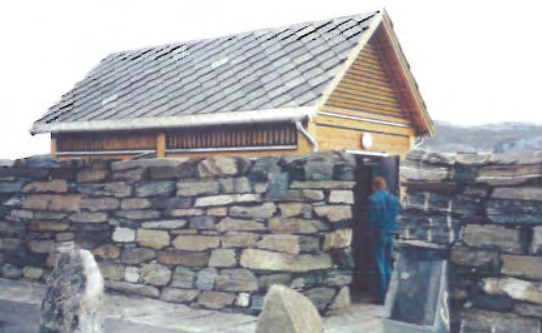
Oscarshaug, Rv 55 i Sogn og Fjordane. Skifermuren har blant annet funksjon som leskjerm for snø og vind. Foto: Trine Kanter Zerwekh.
