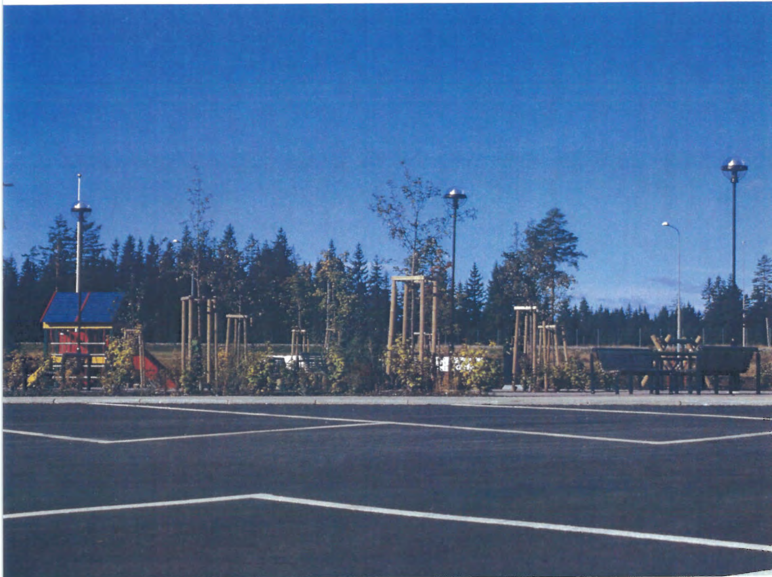
Jessheim, E6 i Akershus. Her er oppstillingsplassene lagt tett inntil rastearealet, avgrenset med kantstein. Foto: Unni Haugtun.
