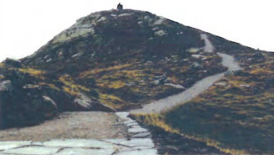
Oscarshaug, Rv 55 i Sogn og Fjordane. Her er haugen fotografert med standpunkt på rasteplassen, etter at tiltak er gjennomført. Det er anlagt sti opp til toppen samtidig som slitasjeskadene er utbedret. Foto: Monica Bente Gjerde.
