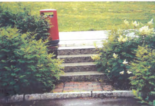
Ramsum, E18 i Vestfold. Høy kvalitet på materialer og utforming, men dette er en lite «rullestolvennlig» måte å utligne høydeforskjeller på. Foto: Øivind Luke.
