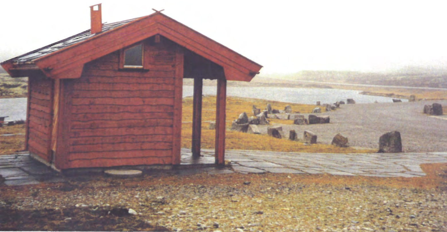
Muen, Rv 27 i Hedmark. Her er toalettbygget plassert på en høyde. Kanskje blir det for dominerende?
