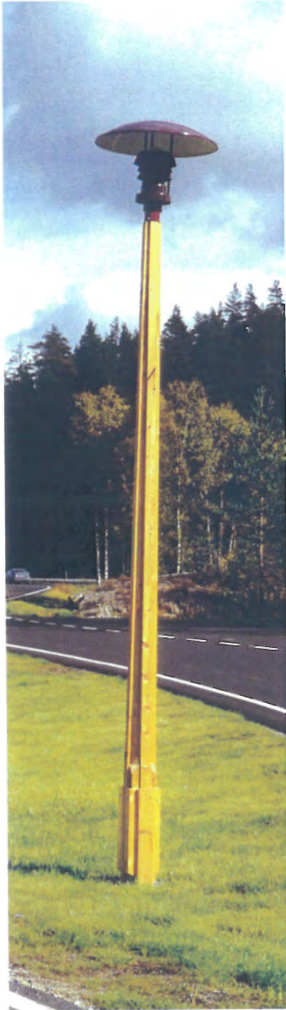
Østerholtheia, E18 i Aust-Agder. Eksempel på belysningsutstyr. Selv om dette er ved rampen inn til rasteplassen er det valgt en parkmessig belysning. Foto: Bjarte Sandve.
