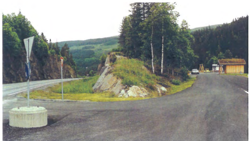
Eggafossen, Rv 30 i Sør-Trøndelag. Her danner fjellknausen en effektiv støyskjerming mot riksvegen. Foto: Gunnar Tørud.
