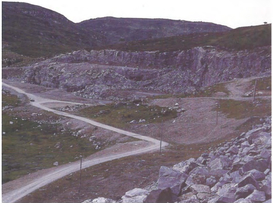
Fig. 4 Steinbruddet er forlatt uten at det er utført istandsettingsarbeider. Tokkeverkene ved Songadammen, Rauland kommune i Telemark.
