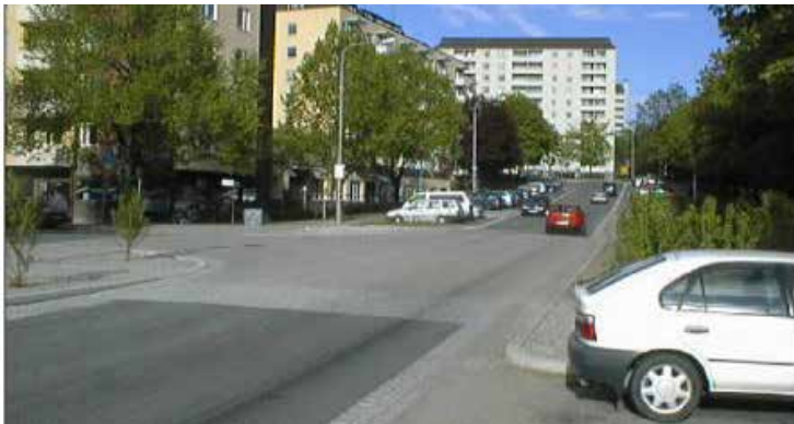
Figur 3.14 Opphøyd kryss (Bilde: Sweco)
