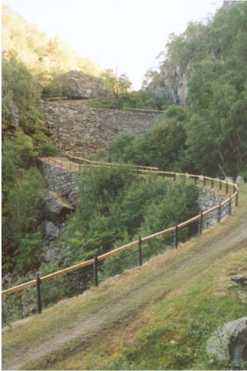
Figur 5.1 Vinhellavegen (Foto: Ingerlise Amundsen)
