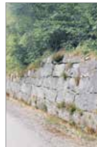
Fint håndverk, jevn overflate og murkrone
