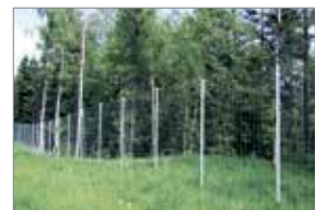
Viltgjerde med runde stolper
