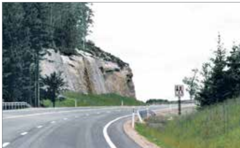
Ensidig fjellskjæring. Bredere profil med varierende avstand
