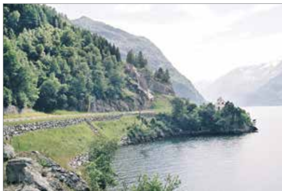
Mur som er tilpasset fjellet og steinen i området
