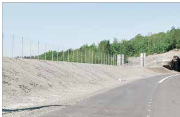
Støyvoll med en unødvendig streng form. Gjerdet på toppen bedrer ikke inntrykket
