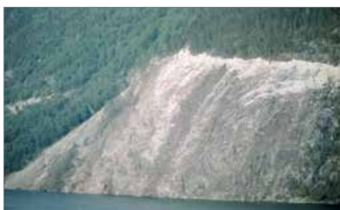
Vegen skal ikke ligge på sidebratt terreng uten forankring i mindre terrengformer
