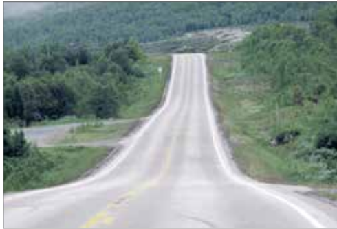
Korte vertikalkurver bundet sammen av en rettlinje
