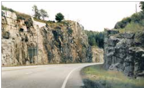
Tosidig fjellskjæring, vanlig utformet
