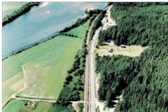
Vidt dallandskap. Her er randsonen mot skogen ikke sammenfallende med overgangen mellom bratt og flatt. Vegen og jernbanen ligger delvis i randsonen. Bebyggelsen ligger langs vegen
