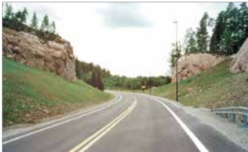
Fjellskjæringen er formet med koter. Uten forming ville skjæringene vært ca. 20 m høye
