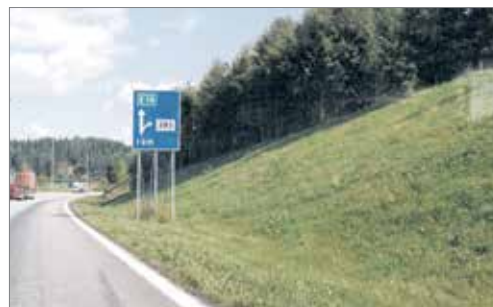
Vanlig utforming av jordskjæring. Hellingsvinkel 1:2
