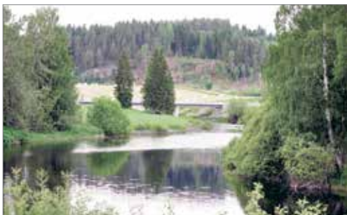
Vegen krysser i bru på det smaleste punktet
