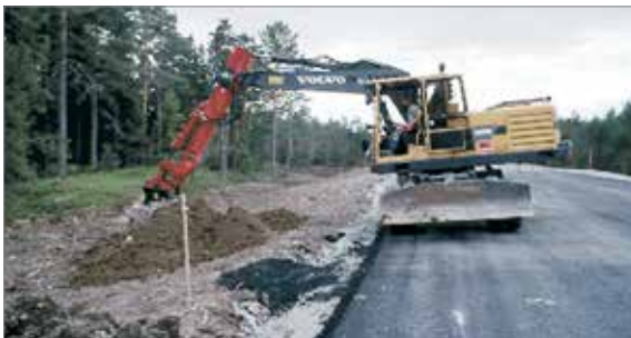
Utlegging av jord med gravemaskin
