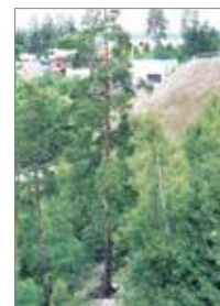
Høy fylling, skjermet av vegetasjon, helling 1:1,25
