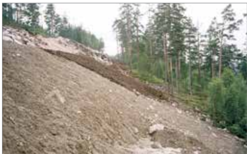
Lagvis utlegging av jord
