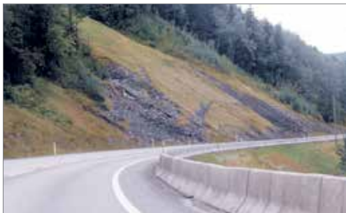
Erosjon som følge av for bratt skjæring
