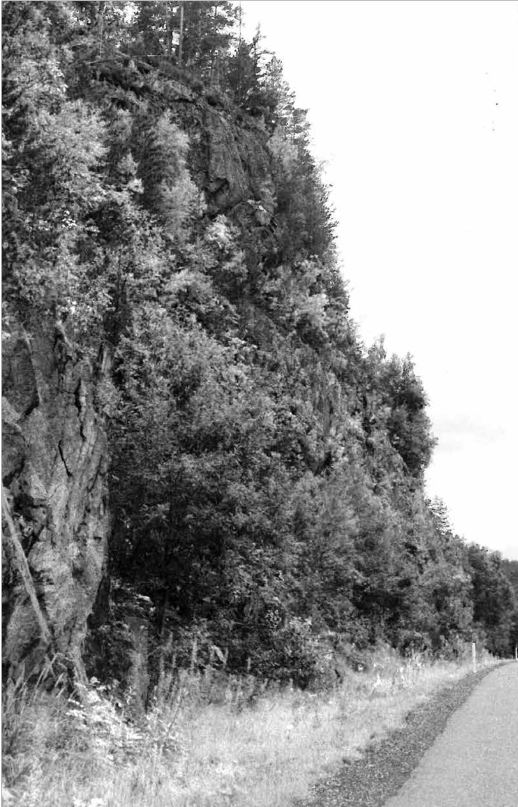
Gammel fjellskjæring dempet med vegetasjon
