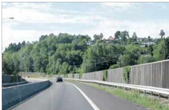
En tradisjonell løsning. Treskjerm med guardrail
