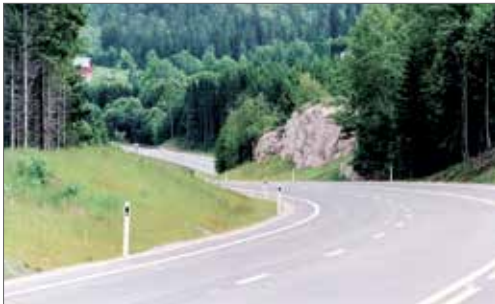
Sprang forårsaket av terrengform
