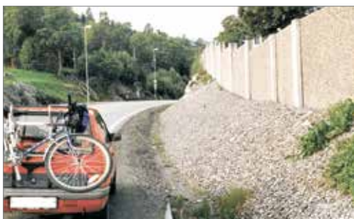
Støyskjerm av prefabrikerte betongelementer
