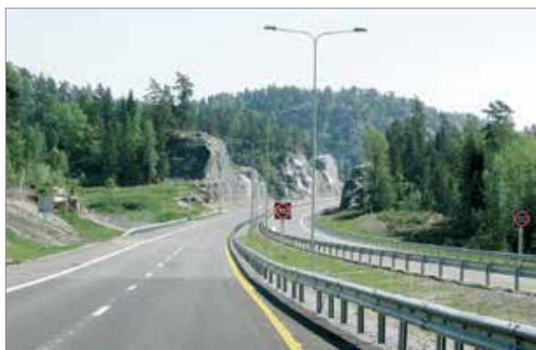
Rekkverksskinne med w profil og stålstolper
