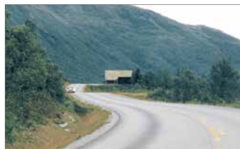
Dårlig kontinuitet i romkurven
