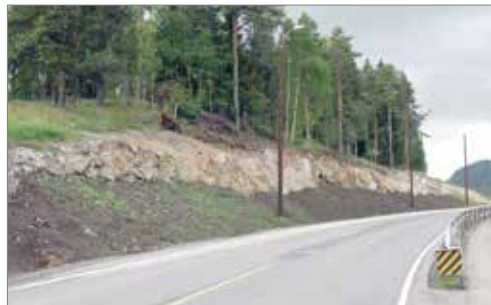
Ensidig fjellskjæring, utformet med jordskråning opp mot fjellet er mindre skjemmende
