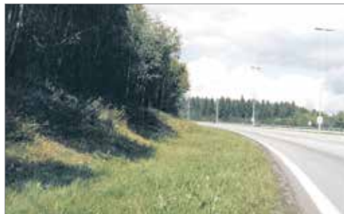
Lukket drenering med grunn sidegrøft gir visuelt god form
