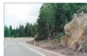
Virkning av nisje etter at vegetasjonen er etablert
