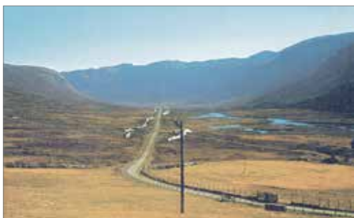
Vegen skal ikke ligge på åpen flate
