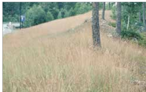
Tilsåing med gress markerer grensen for inngrep
