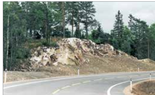
Ensidig fjellskjæring som skulpturelle former. Fjellknatter som bryter opp jordskråningene gir et naturlig preg
