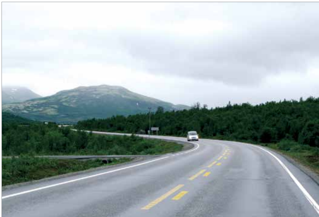
Landformen har størst betydning. Vegen ligger inntil, men ikke i overgangen mellom bratt og flatt
