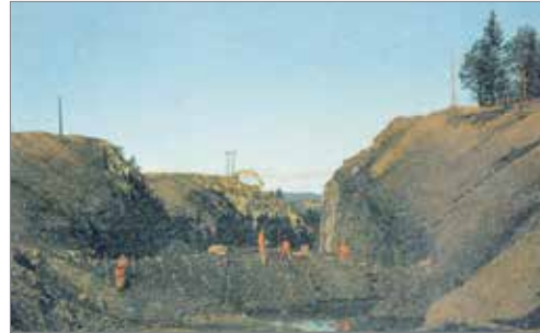
Toppen sprengt ned
