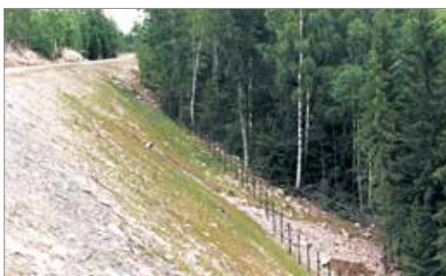
Vanlig utforming av fylling. Hellingsvinkel 1:2
