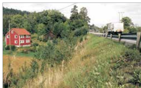
Høy, tosidig fylling. Huset ligger isolert og i en bakevje
