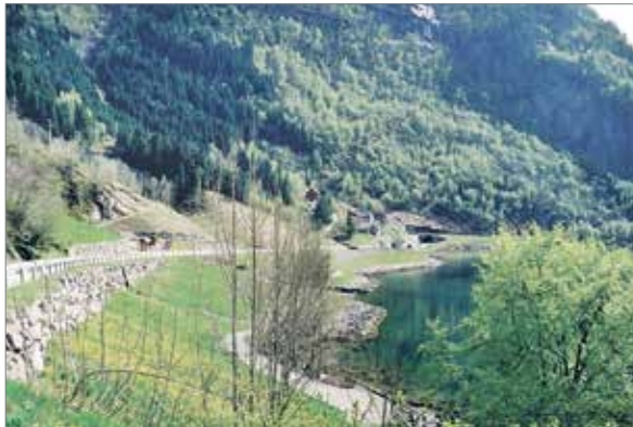
Lav mur og fylling med god tilpassing til terrenget
