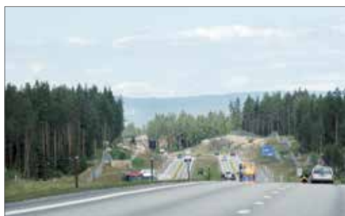
Sprang i vertikalkurven kombinert med sideforskyvning horisontalkurven, gir dårlig kontinuitet i romkurven
