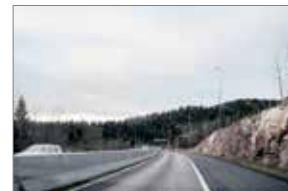
Midtrekkverk i betong
