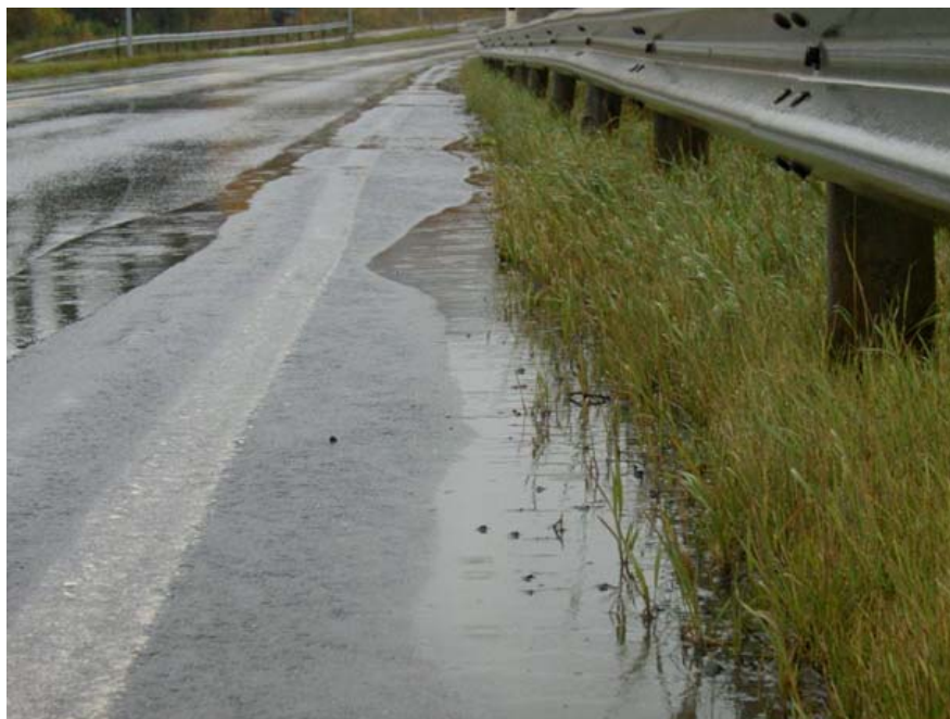
Figur 11 Eksempel på vann i hjulspor og vann som blir stående mot torvkant [2]
