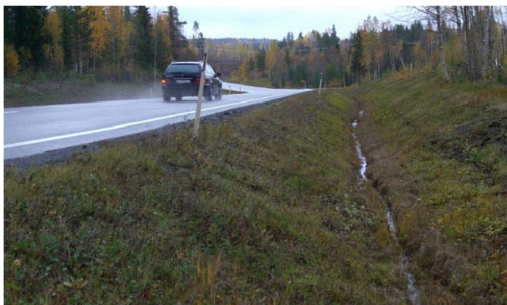
Figur 12 God avrenning fra kjørebane og velfungerende sidegrøft
