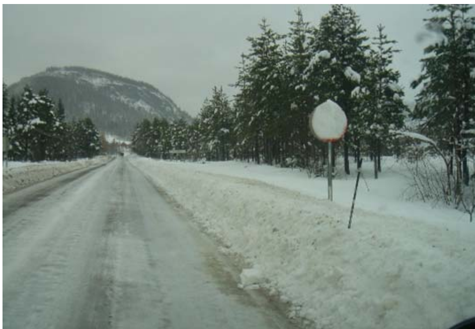
Figur 7 Våt is (hålkeføre) uten strøtiltak, friksjonskoeffisient 0,10-0,15. Rv. 705 8. januar kl 11:45 [2]
