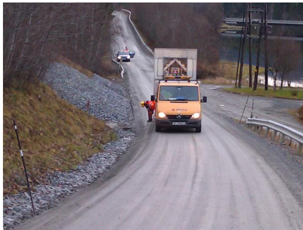
Montering av transpondere
