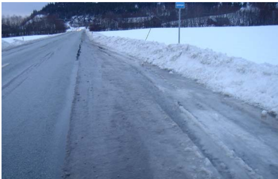
Figur 5 Is dekker kantlinjen etter lengre periode uten nedbør, E14 8.januar 13:08[2]
