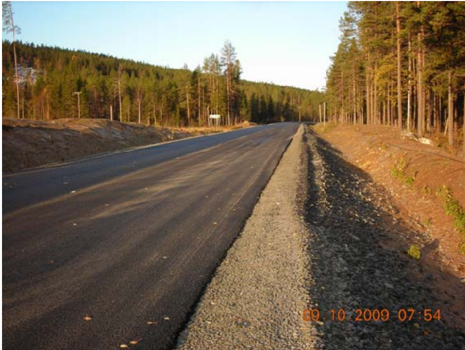
Figur 14 Forsterket veg med asfaltdekke og god skulderbredde
