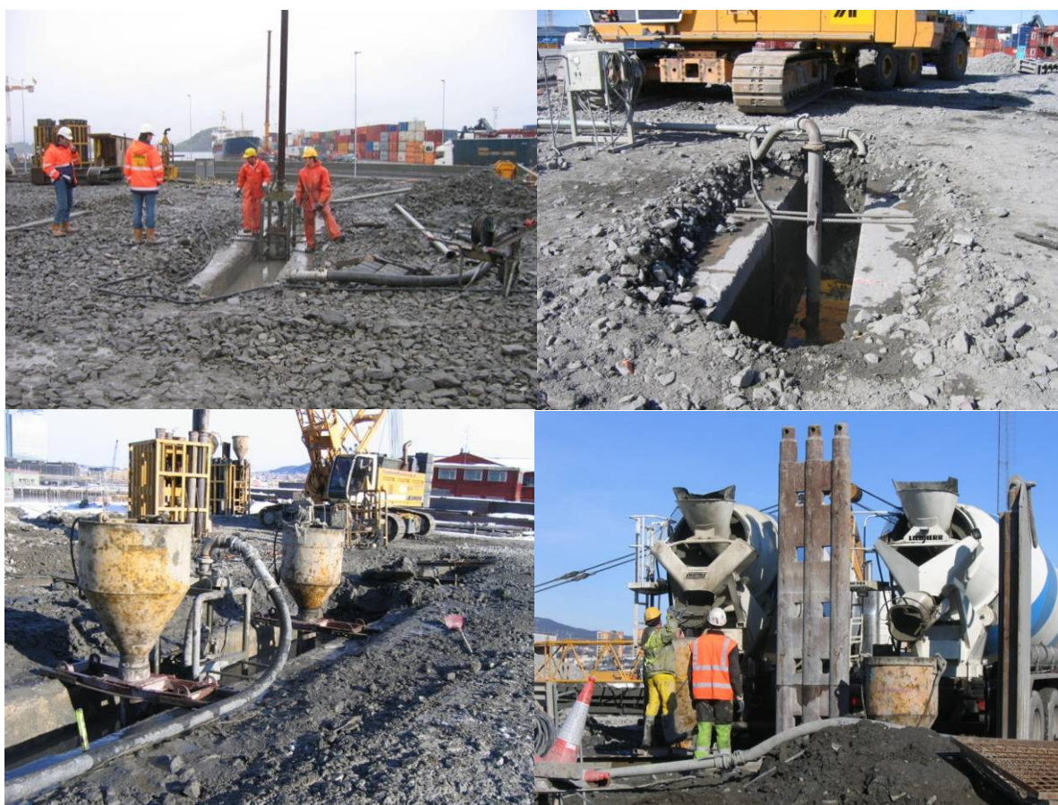
Fig 5.16 - Gjennomføring av støpearbeidene
