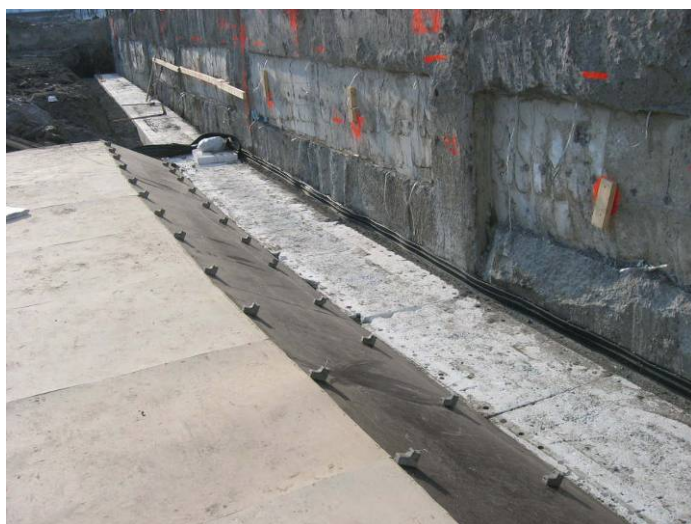
Fig 3.14 - Fortanning slik de ble i slisseveggene.
