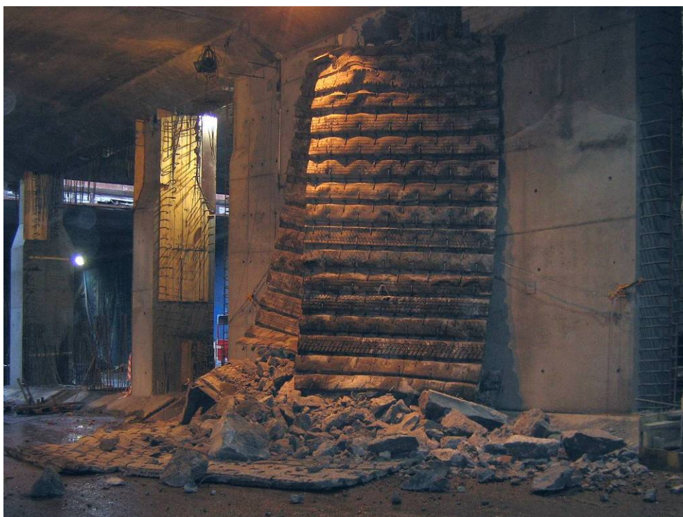
Fig 10.5 - Sliss etter sprengning
