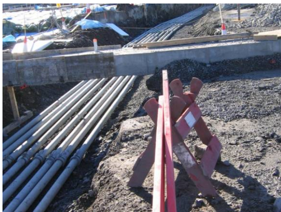
Fig 5.9 - Rør lagt for omlegging Havnevei og E18
