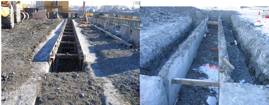
Fig 5.4 – Ferdig støpte ledevegger
