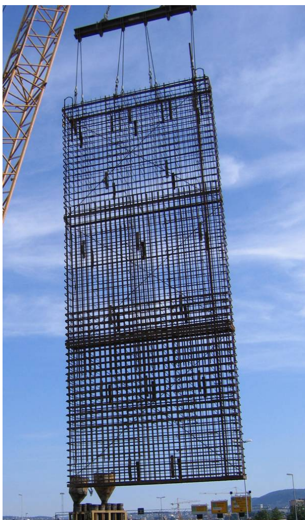
Fig 6.6 - Armeringskurv med helningskanal til høyre
