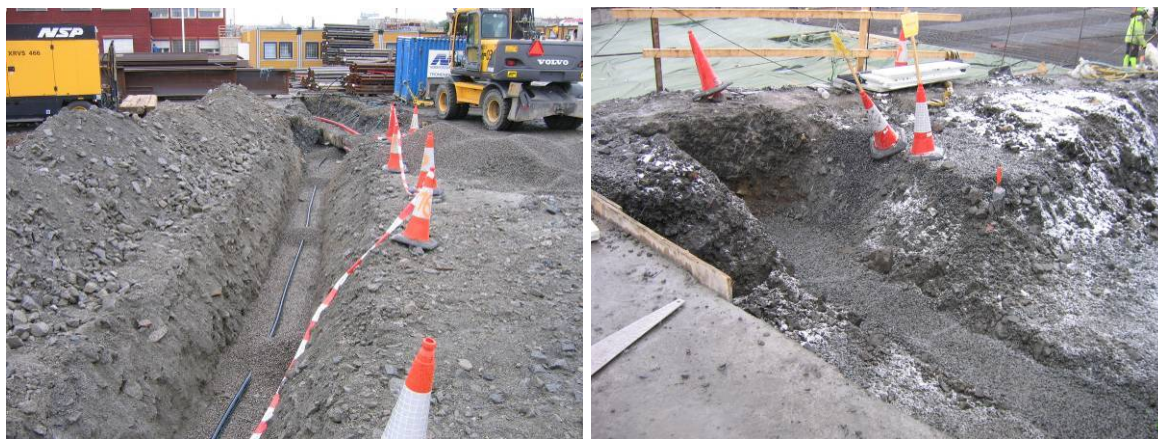
Fig 8.5 - Grøft for montering av slangesetningsmålere
