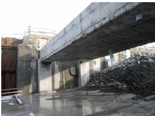
Fig 3.18 - Stiver over takplate midlertidig understøttet på pilarer ved nordveggen.
