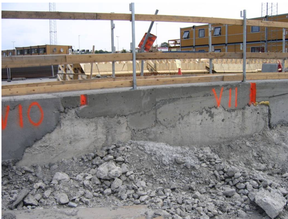
Fig 8.7 - Setningsbolter på slissevegg
