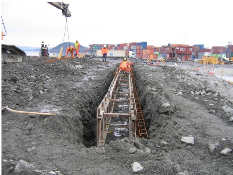
Fig 5.3 – Ensidig forskalling for ledevegger
