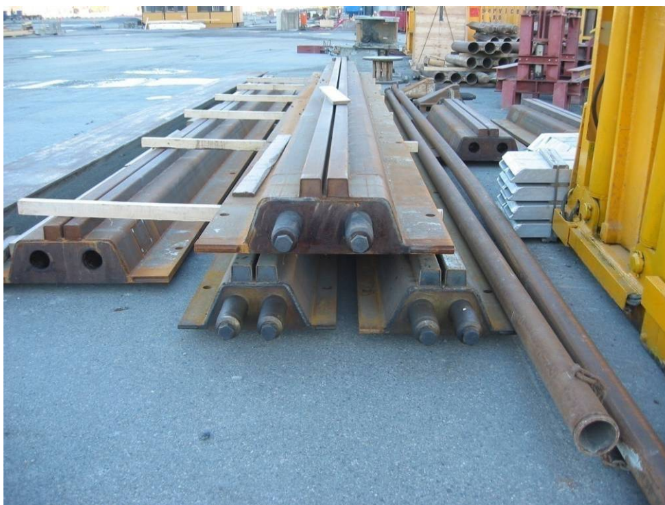
Fig 5.11 - Eksempel på Bachy-endesteng.
