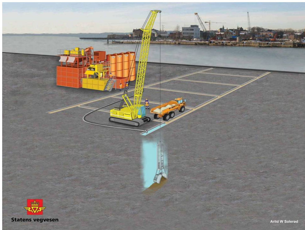
Fig 1.4 - Graving av slissegrøft
