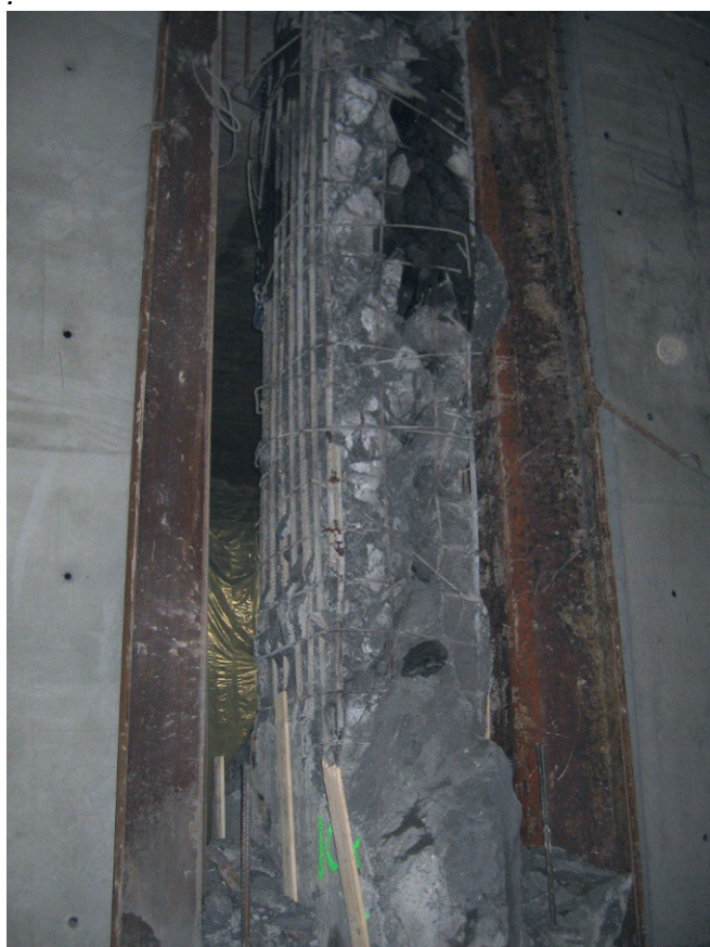
Fig 10.6 - Sliss etter sprengning
