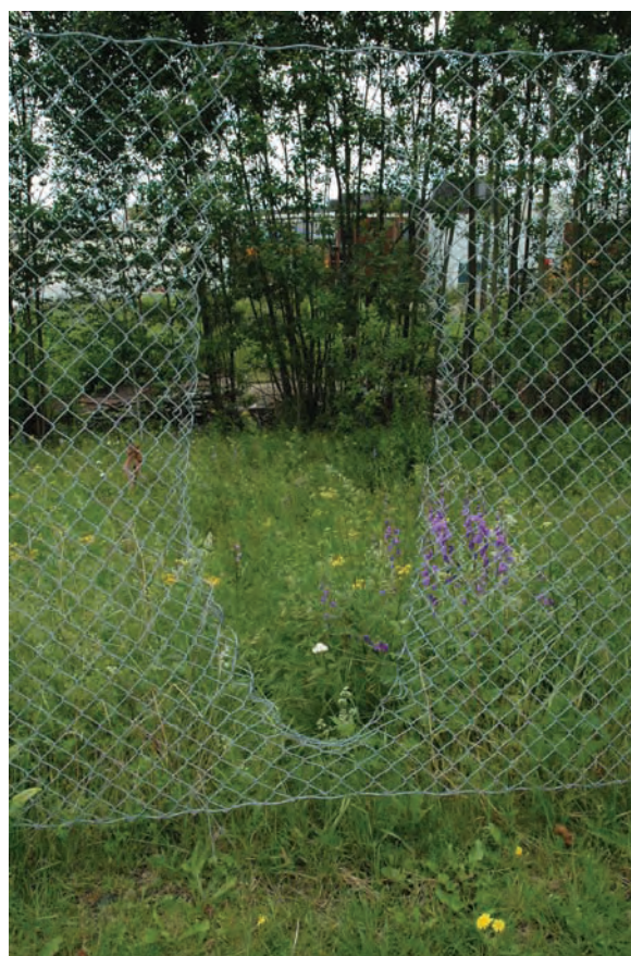
Eksempel på et ulovlig hull i gjerdet mellom gang- og sykkelveien langs Ring 3 og jernbanelinjen.
