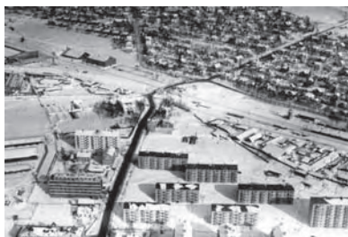
Flyfoto av Storokrysset anno 1954. Foto: V. Skappel, utlånt av Oslo byarkiv.
