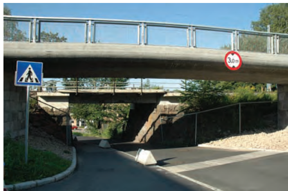
Undergang (1) under jernbanebroa (i forgrunnen overgang for gående og syklende).
