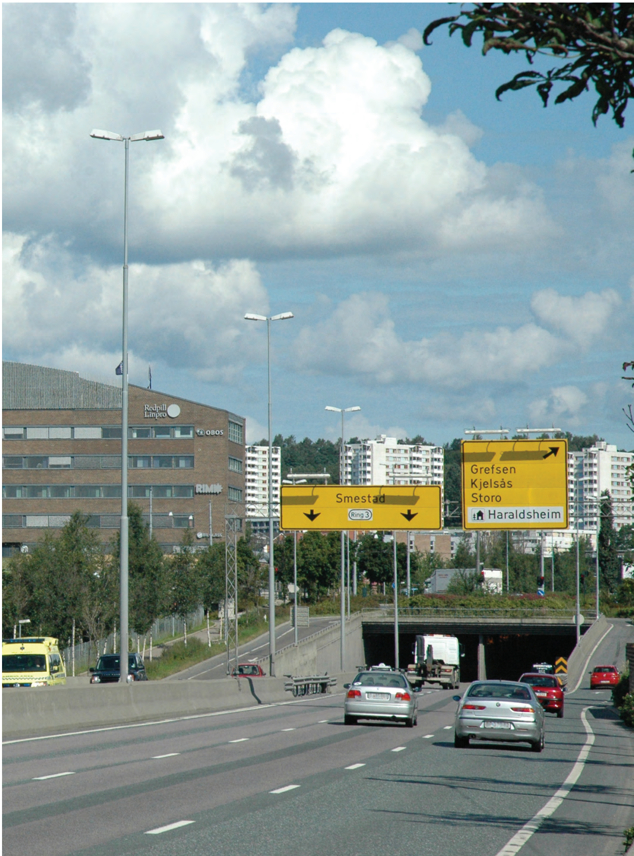
Storokrysset anno 2011. Ring 3 går i kulvert under krysset. Ramper fører opp til et signalregulert kryss.
