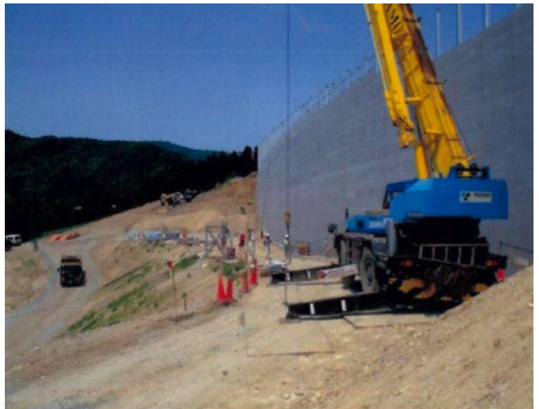
Figur 5.19: Oversiktsbilde fra byggeperioden. (Slobodinski og Aunaas, 2010).
