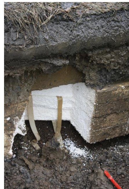
Figur 8.6: EPS-fyllingen kom til syne. (Lindqvist, 2011).
