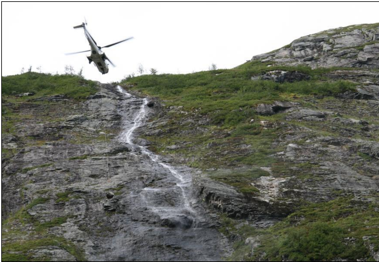
Figur 5.6 Sleggerensk med lodd hengende i "longline" under helikopter (Foto K. Brattlien, NGI).
