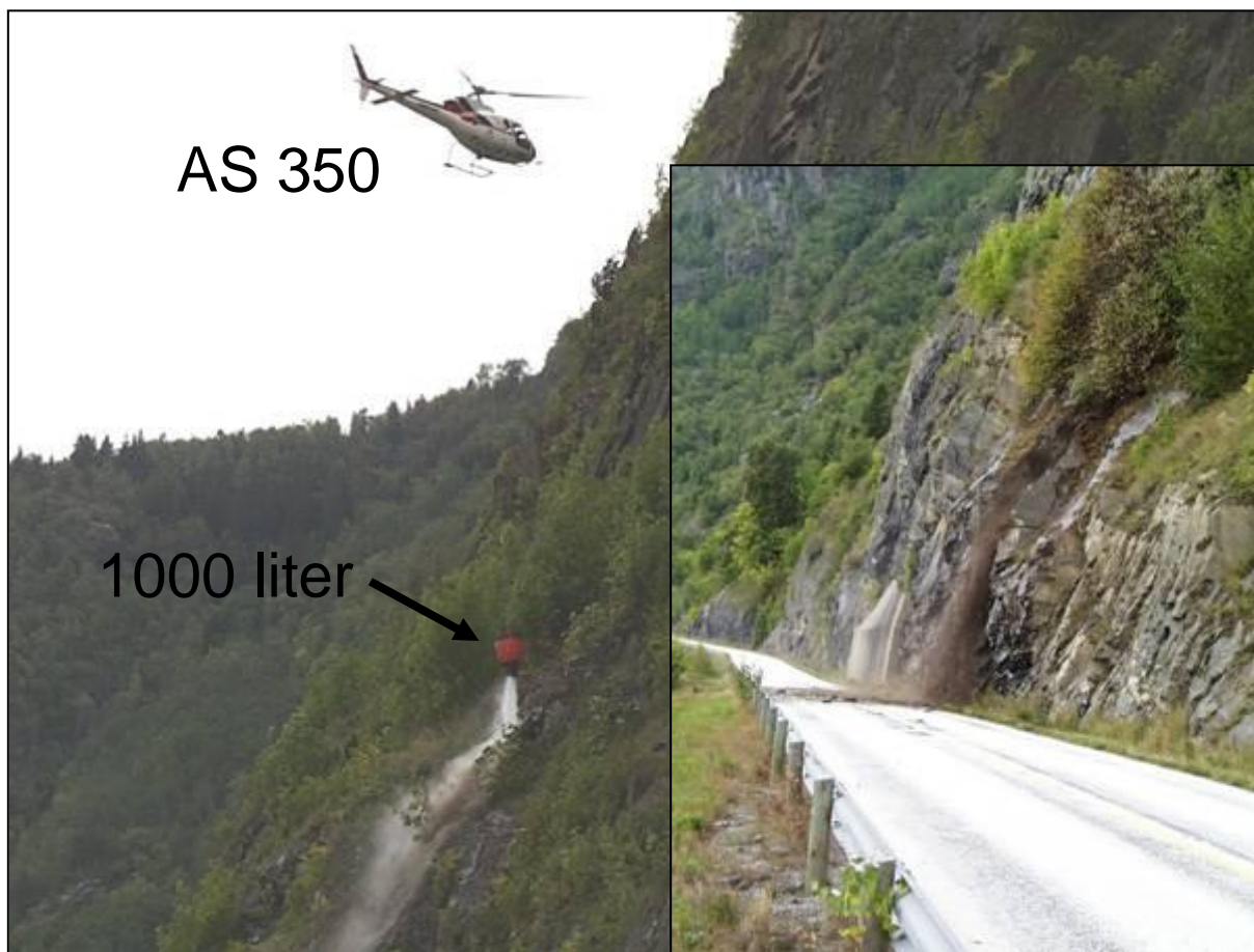
Figur 5.5 Helikopterspyling med 1000 liter sett fra terrenget og vegbane. Helikopteret som er brukt er av typen AS 350 og her operert av Airlift A/S. Foto: S.H. Frækaland, SVV.
