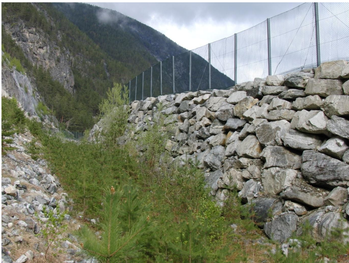
Figur 5.19 Eksempel på fangvoll med tørrmur og toppgjerde fra Mannhiller i Sogn og Fjordane. Fangvollen er høy og kraftig med bratt side mot fjellsiden bygget som tørrmur. Den skal kunne stanse større steinsprang som kommer i stor fart. Toppgjerdets hensikt er å stanse flogstein eller steinfragmenter som slynges ut under knusning av større blokker i nedslag ovenfor vollen.
