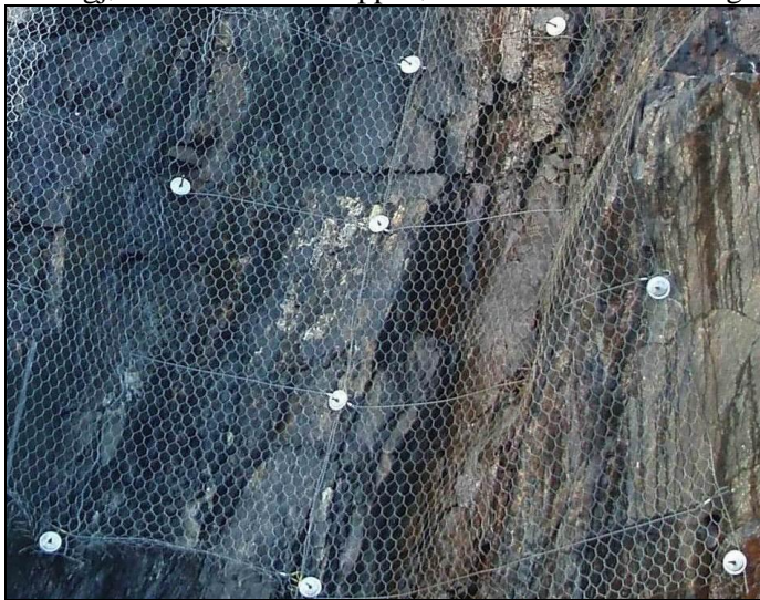
Figur 5.14 Steinsprangnett med innsydd wire (Maccaferri "Steelgrid", foto: Fjellrenovering AS)
