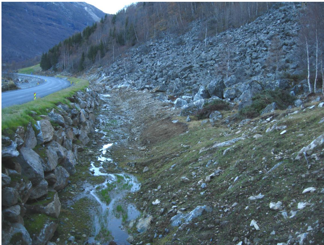
Figur 6.4 Sikring av vegen ved Eråksøyne (Foto: Ulrik Domaas, NGI).
