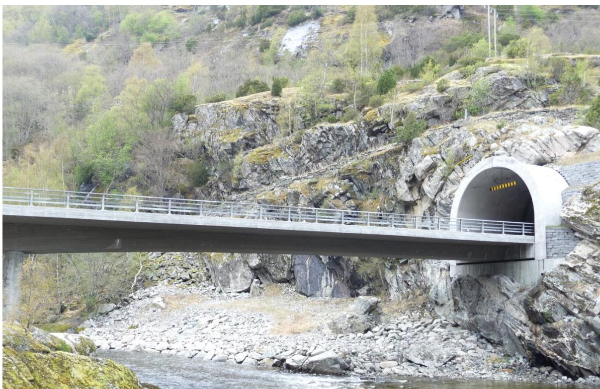
Figur 6.7 Tunnel mellom Øygarden Fremre og Voldum. Bildet viser bru og påhugg ved Øygarden Fremre, Lærdal. Overdekningen er liten ved påhugget og sikring og sprengning var krevende for å unngå at den gamle vegen over ble ødelagt (Foto: Ulrik Domaas, NGI).
