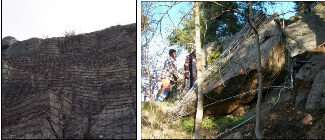
Figur 5.13 Til venstre: Wirenett bestående av flettede stålringer ("ubåtnett", foto: Betongrenovering AS). Til høyre: Nett av typen Geobrugg "Spider" (Foto: K. Moen, Multiconsult AS)
