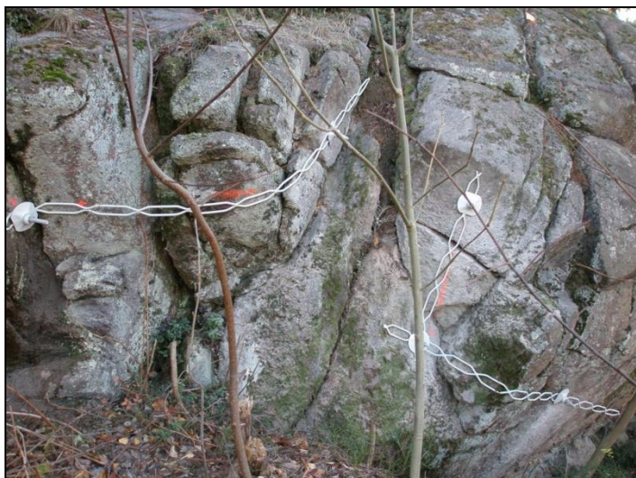
Figur 5.15 Sikring av ustabile blokker med fjellbånd. (Foto: K. Moen, Multiconsult AS)
