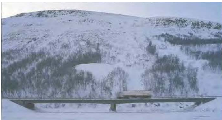
Fig 8.9. Eksempel på bru bygd som sikringstiltak mot skred
