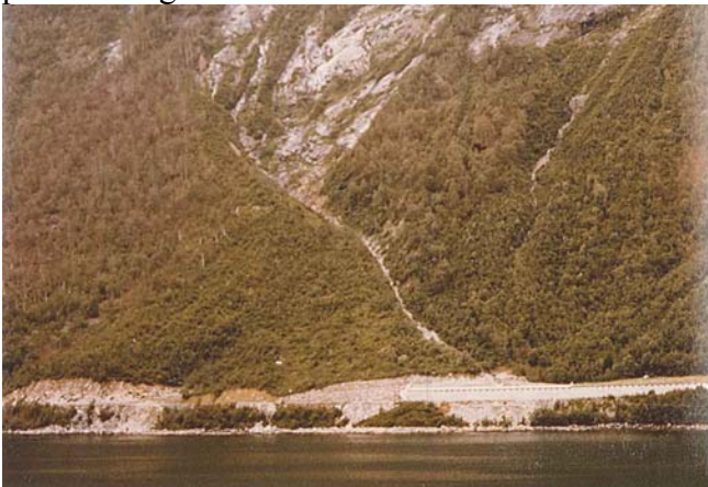
Figur 5.6. Foto av fjellside hvor en rygg i terrenget styrer de tunge skredmassene mot overbygget, mens større skred og snøskydelen av skredene går rett fram og sperrer vegen på venstre side av overbygget, Fv 655 Bustene, Møre og Romsdal. (Foto: H. Norem)
