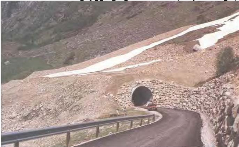
Figur 8.8. Eksempel på overbygg bygget med korrugert stålrør og tilbakefylling av løsmasser. Fv 337 Veitastrand, Sogn og Fjordane. (Foto H. Norem)
