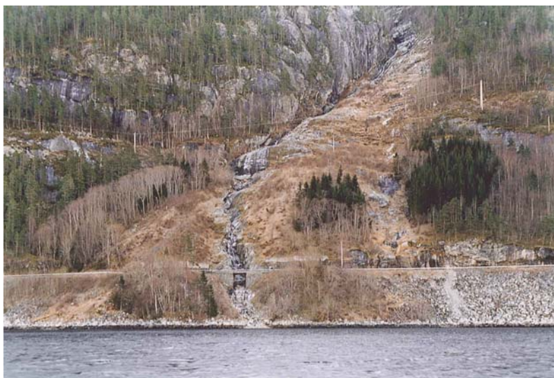
Figur 4.6 Foto av et skredområde hvor de hyppigste skredene følger bekkedalen, mens større skred og snøskydelen i mindre grad styres av forsenkninger og rygger, Indre Rotagjelet, Rv 7, Hordaland. (Foto: H. Norem)
