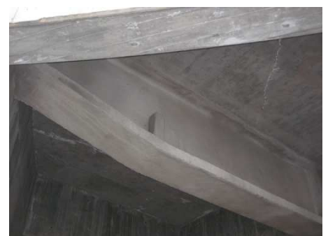
Lysaker lokket E18. Procem Topcoat på Fireshield Ic05. Brannsikring av stålkonstruksjoner.
