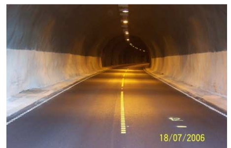
Procem Topcoat i AGA tunnelen
