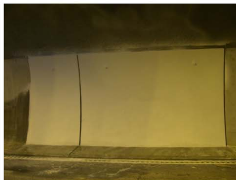
Ferdig sprøytet felt
