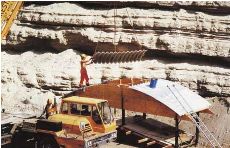
Figur 12. 26 Mal til formontering av plater.
