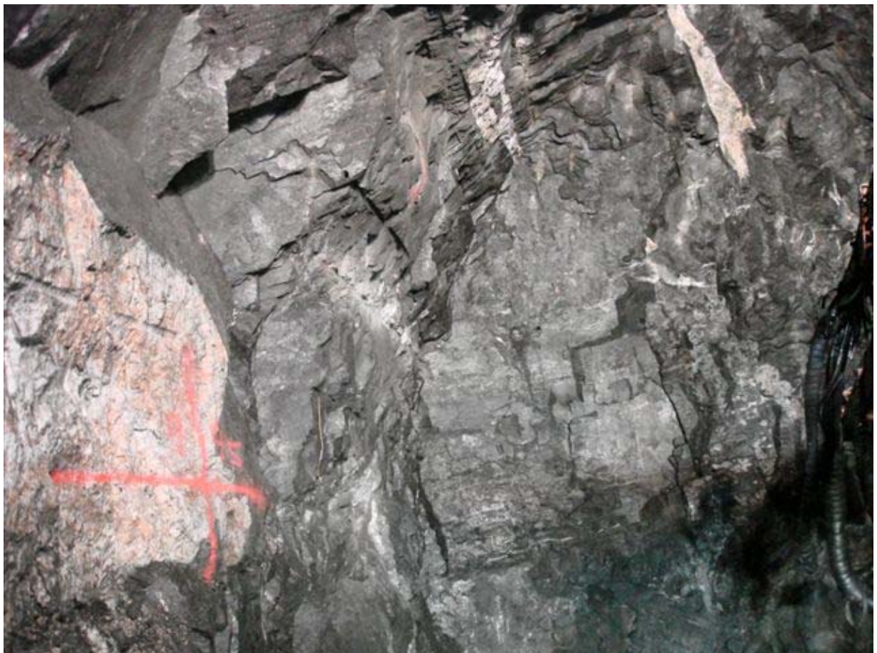
Venstre side av 19.salve ca.profil 940-945. Synes som hardt ladet vegg hull midt på bildet, og utfall forrige salve i bildets venstre øvre hjørne.
