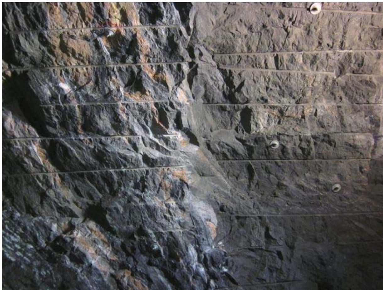
Høyre heng og vederlag 8.salve 883-88, og meste av 7.salve. Stuff til venstre, øvre vegg er nede i bildet. Legg merke til to konvergerende borripene i øvre del av bildet, og sammenlign med forrige bilde.
