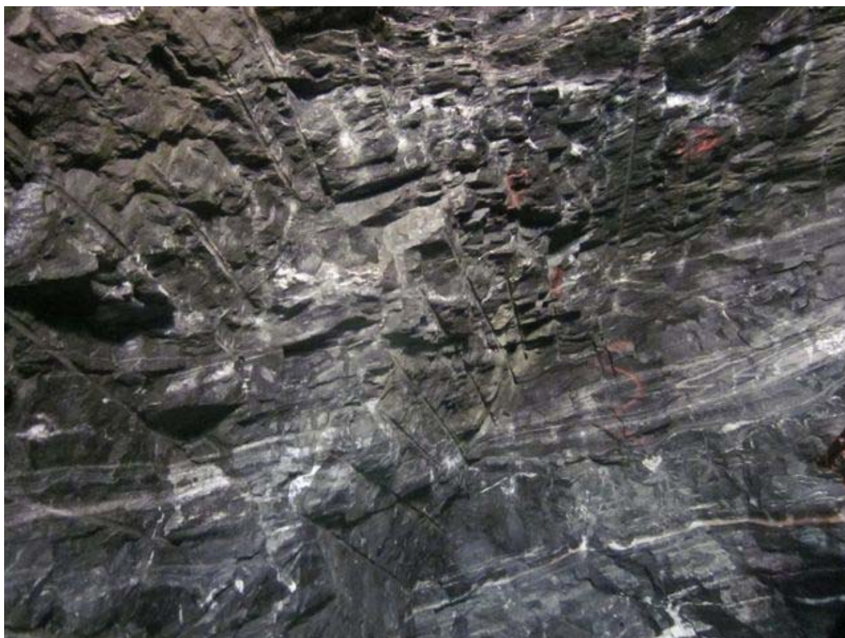
Venstre side 15.salve ca.profil 920-925. Stadig et hakk i venstresiden bak til forrige salve.
