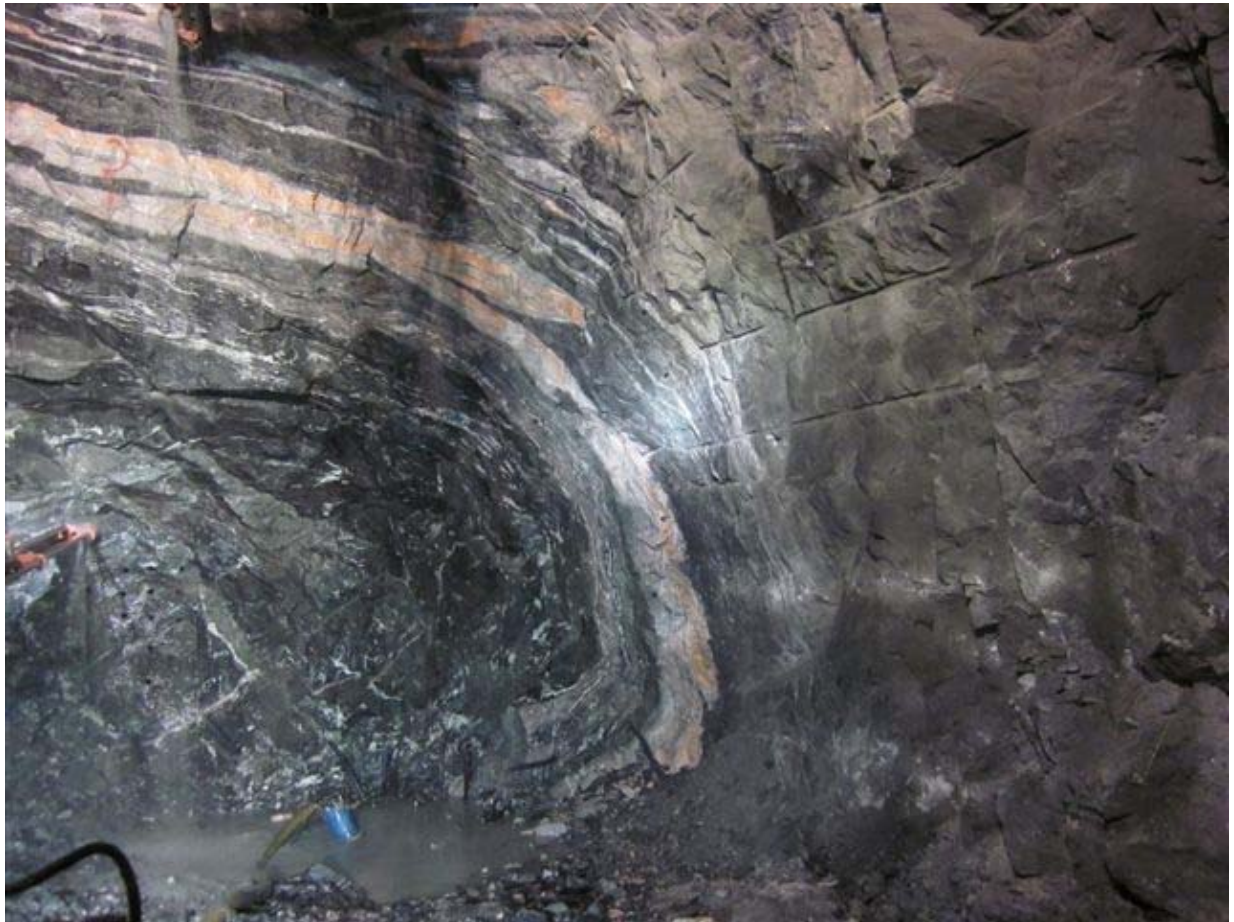
Nedre del høyre side, en ser at veggladingen er noe kraftigere.
