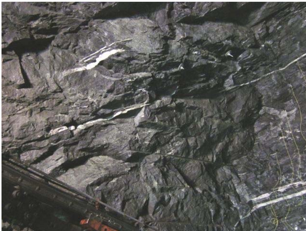
Øvre venstre vegg og vederlag 4.salve 463-68, manglende borpiper og utfall etter foliasjonen (her lett tydeliggjort med lyse, kvartsrike lag) og steile sprekker langs tunnelaksen
