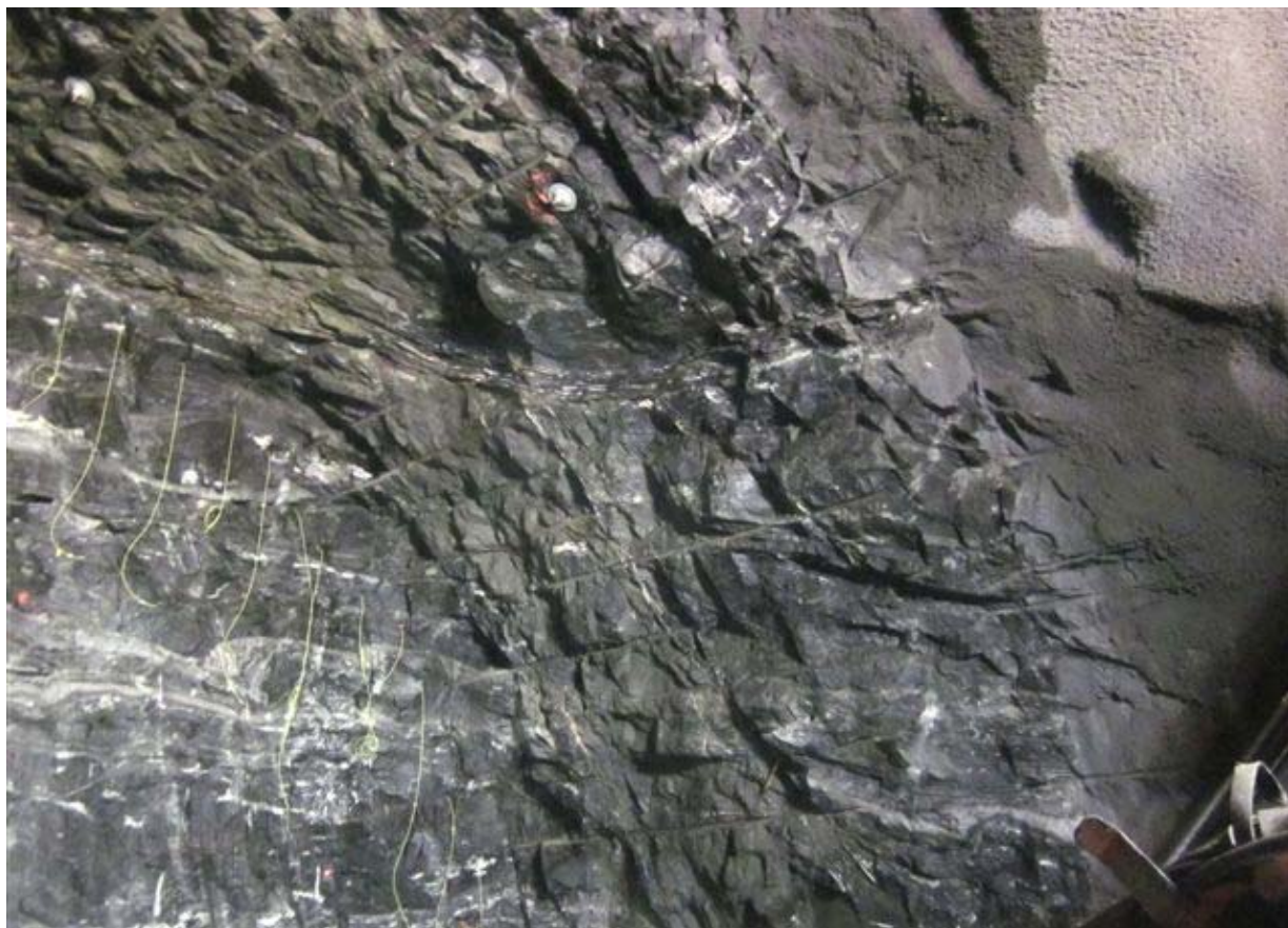
Høyre side 14.salve ca.profil 914,5-919,5. Noe mindre utfall enn venstre side.
