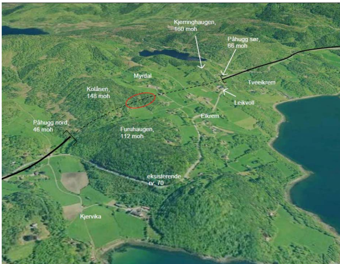
Figur 3 Skråfoto av området ved den nye Eikremtunnelen, som skal bli omtrent 980m lang. Forsøksstrekningen er ringet inn med rødt, der overdekningen er ~65m.
