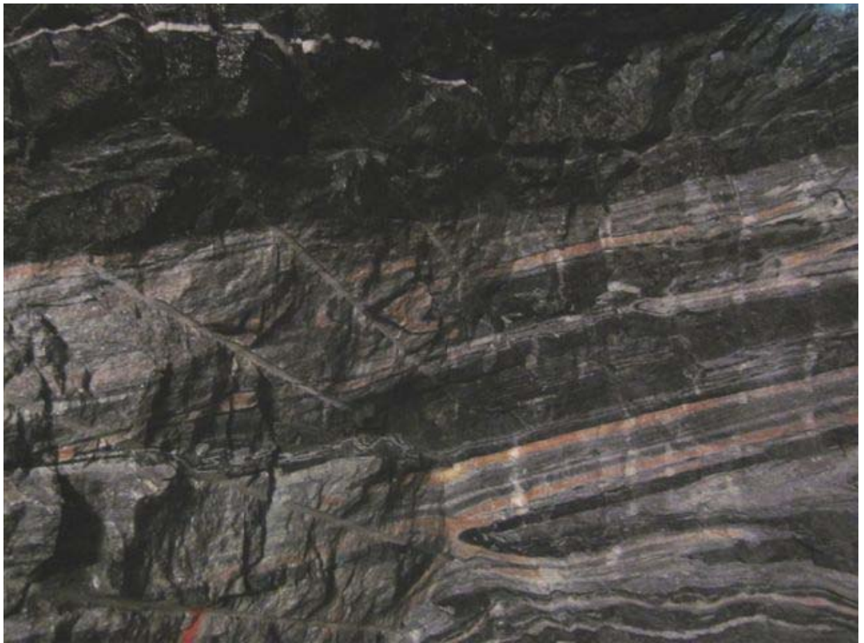
Venstre vederlag i overgang gneis-amfibolitt. Hele borpiper iallfall i gneisen.
