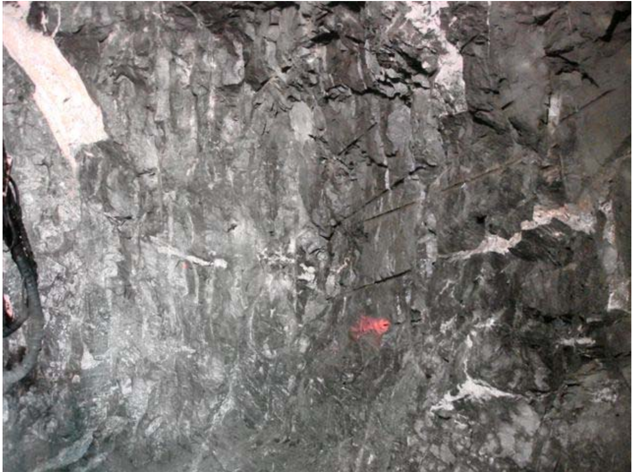
Høyre side 19.salve ca.profil 940-945. Et par konvergerende borhull like til høyre for midten av bildet.
