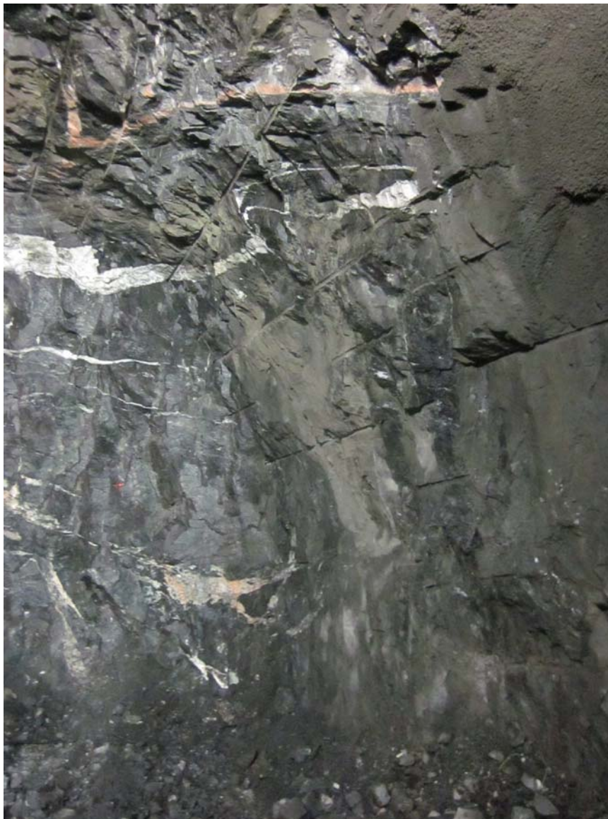
Høyre side 17.salve ca.profil 930-935.
