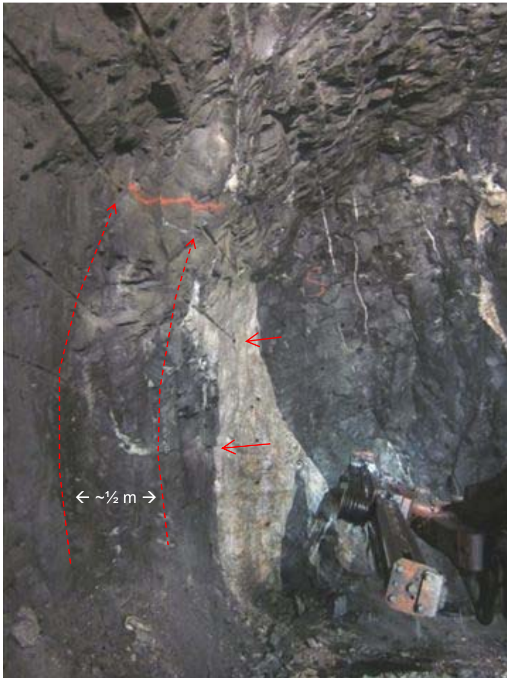
Venstre side 18.salve ca.profil 935-940. Fortsatt god plass på venstre side, over 1/2m. For borpipe med pil, se neste bilde.
