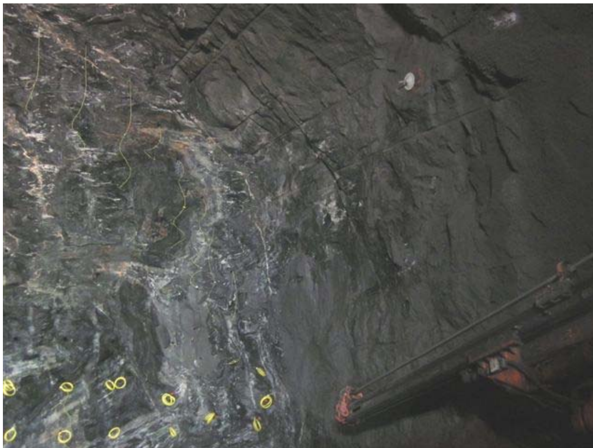
Høyre vederlag-vegg 10.salve ca.profil 893-898,5. Lite borpipe i vegg, det er også ladet relativt hadt her.
