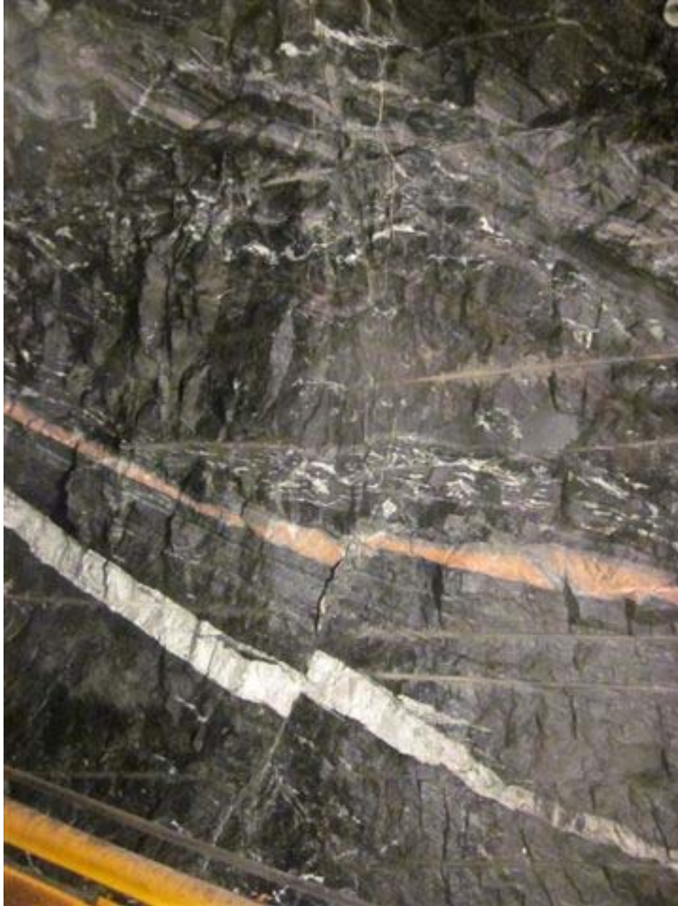
Høyre side; en forkastning i salveskjøten mellom 15.salve med c/c=0,5\text{m} til høyre og 16.salve med c/c=0,7\text{m} til venstre.
