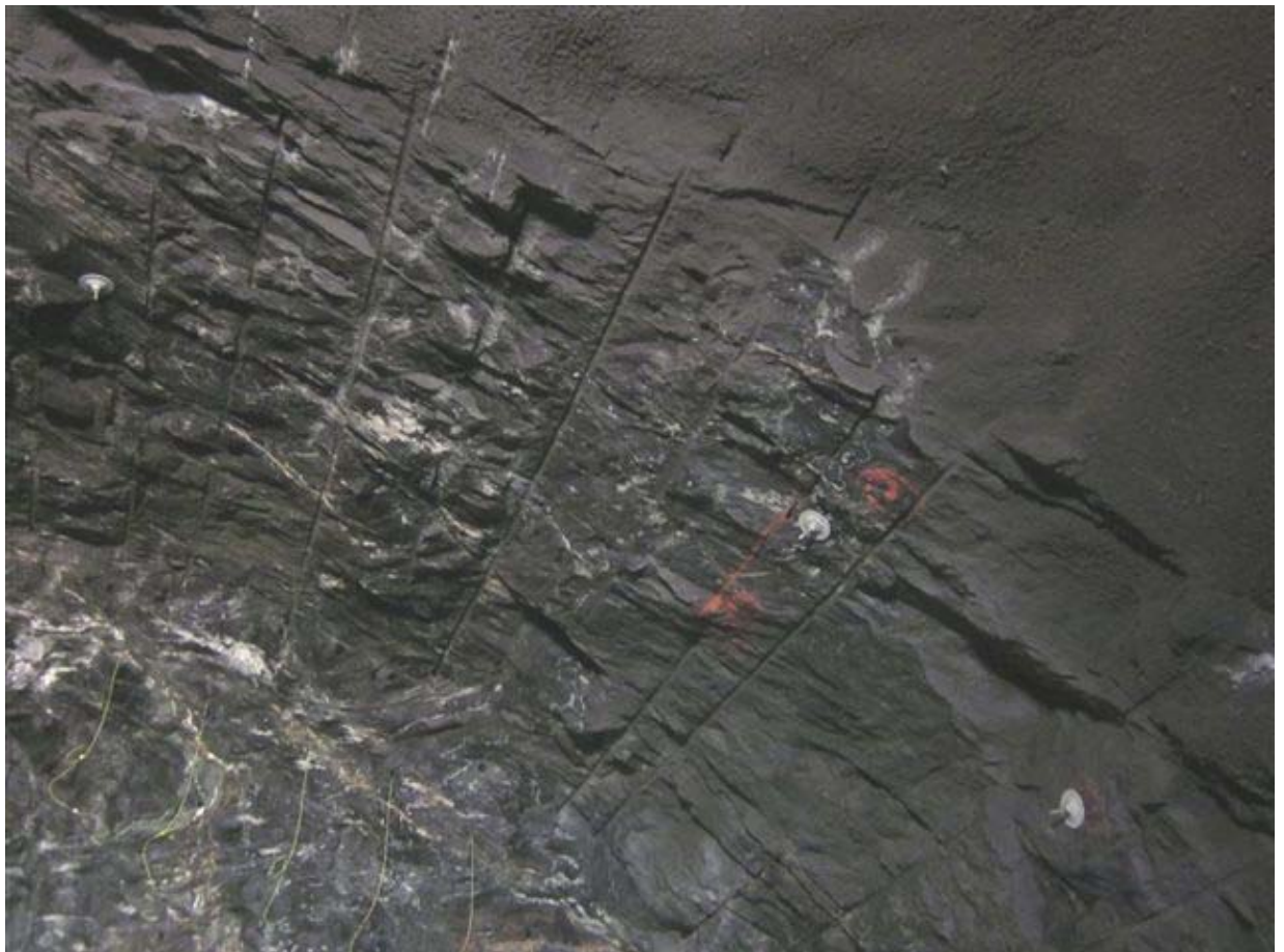
Høyre heng-vederalg 10.salve ca.profil 893-898,5, ikke alltid like parallelle hull.
