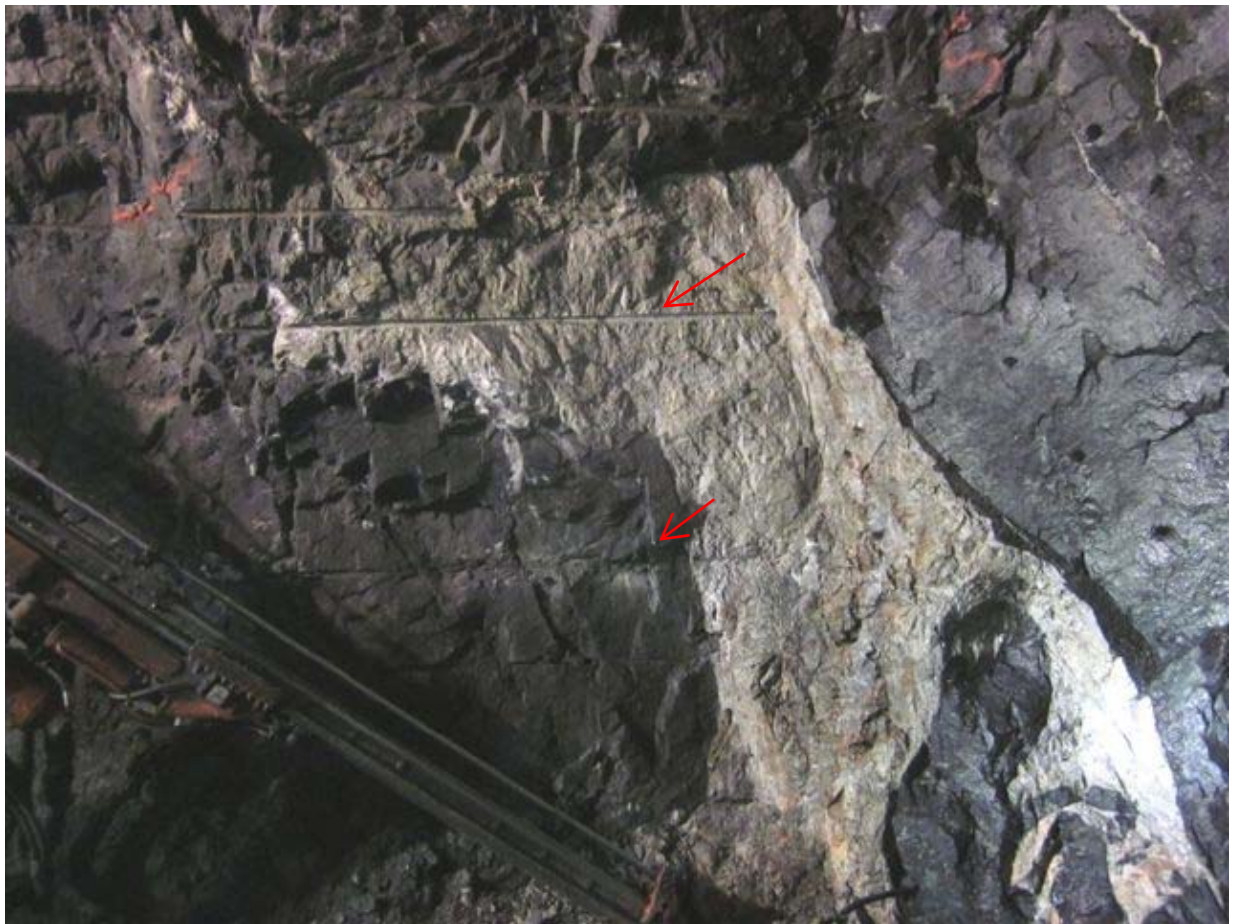
Venstre vegg 18.salve ca.profil 935-940. Piler viser samme borpiper som på forrige bilde, det nederste hullet var åpenbart hardt ladet som innerste hull i bunnstrossen.
