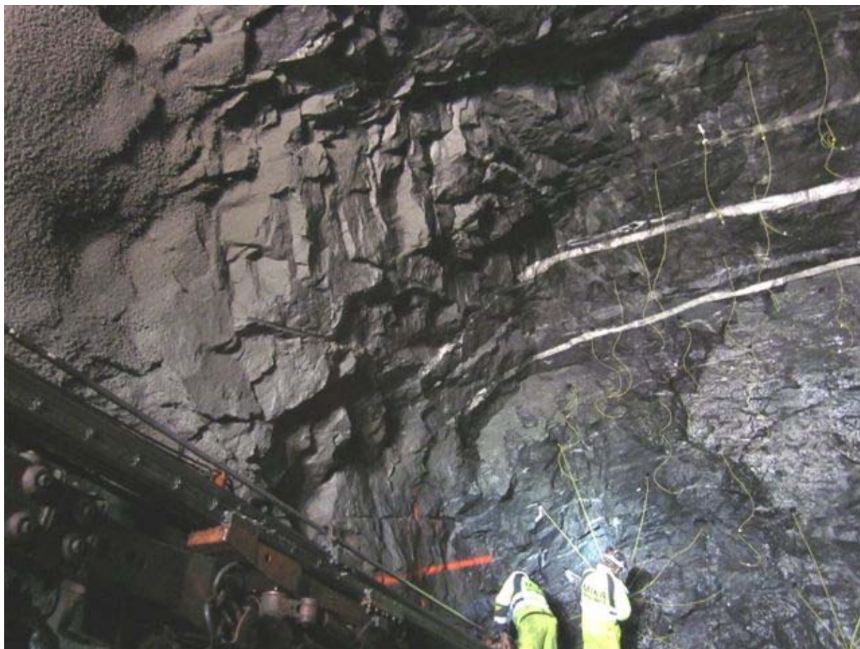
Venstre vegg/vederlag 3.salve, ca.profil 857,5-863.Nedfall og færre halvpipe.
