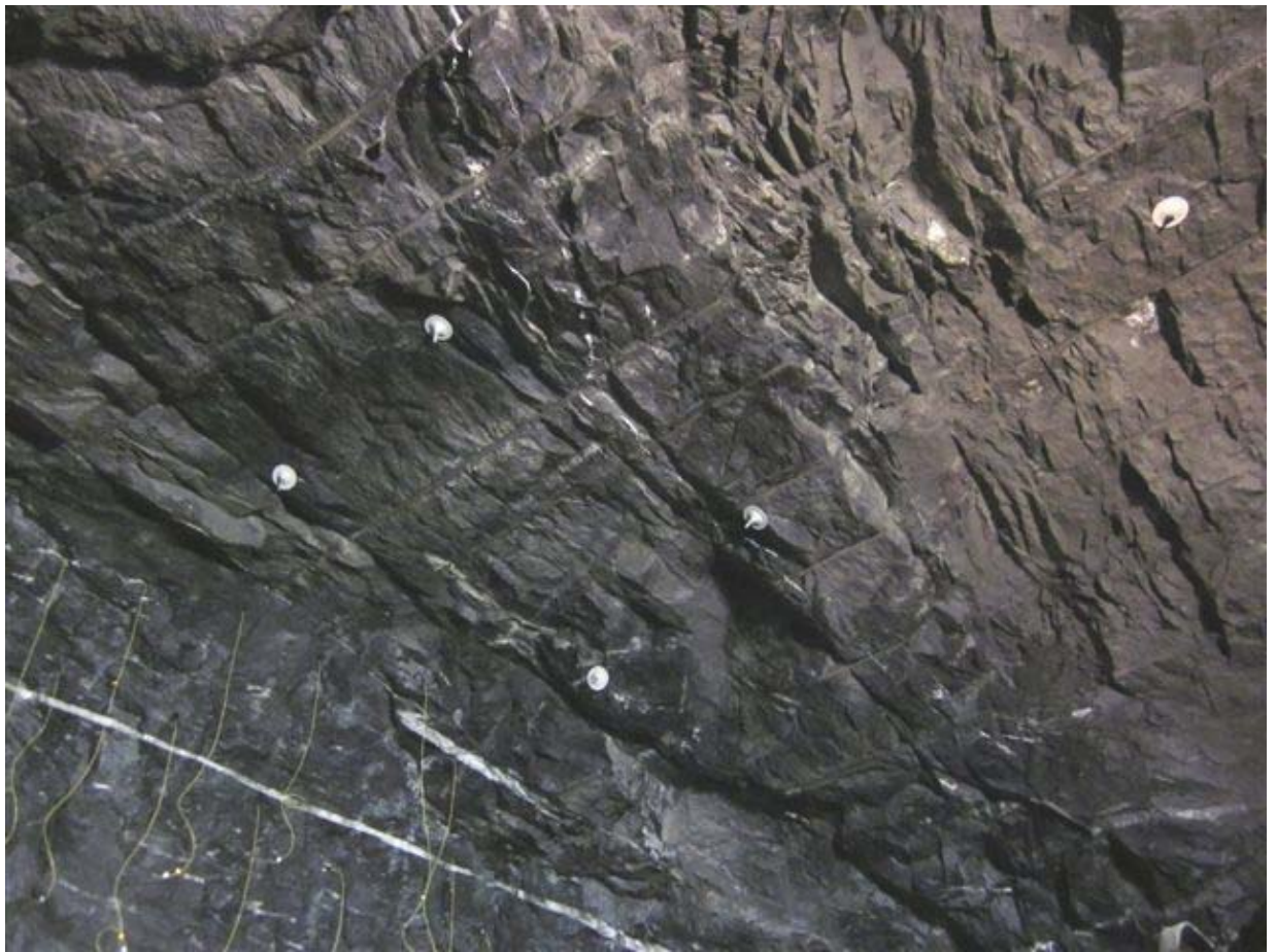
Heng samme salve, overlapp fra forrige bilde. Foliasjonsoppsprekkingen tydelig. Flere synlige halvpiper men allikevel ikke mange.
