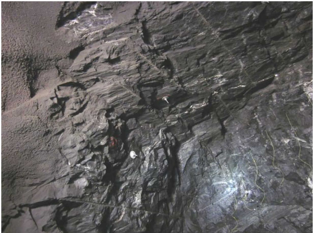
Venste vederlag 10.salve ca.profil 893-898,5, noe utfall grunnet foliasjonsoppsprekking og steile sprekker med liten vinkel til tunnelen.
