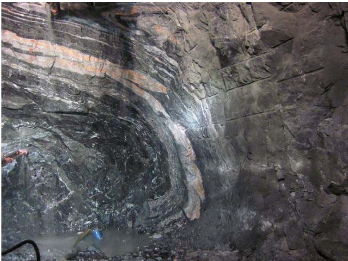
Figur 15 Høyre side 7.forsøkssalve 878-883. Ingen gjenstående borpiper i veggen, kun lyst, knust berg som viser hvor hullene sto. Lenger opp står borpipene nesten uskadet igjen (gule rør).
