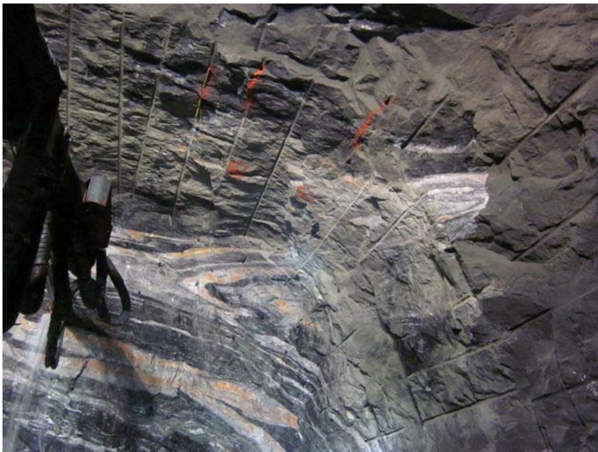
Figur 14 Høyt på høyre side av 7.salve ca.profil 878-883. Mange borpiper, men også utfall og gjenstående knøler. På denne strekningen er marmor-holdig gneis foldet inn i amfibolitten.
