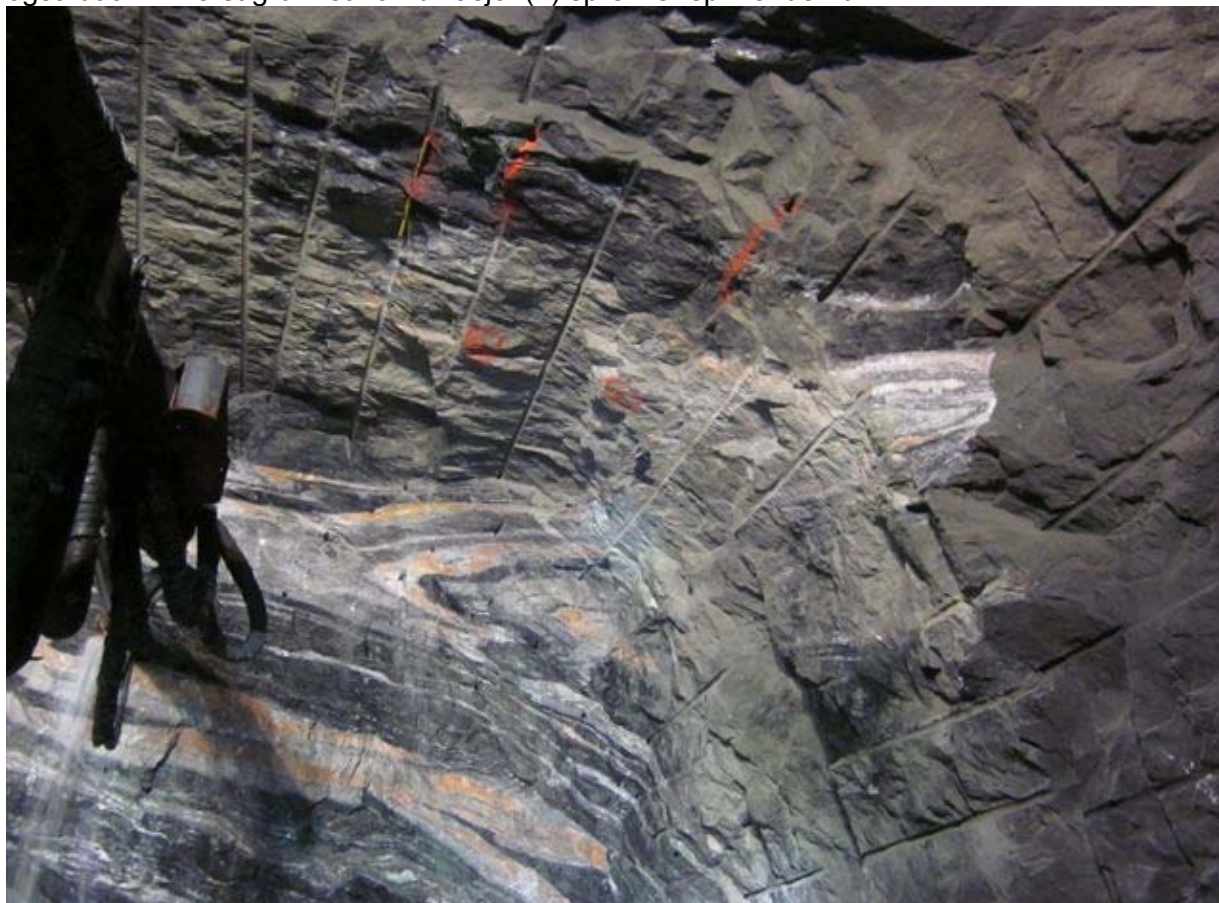
Øvre høyre side av 7.salve 878-83. Tydelig flere borpiper enn da det ble ladet med 3 kg slurry i hullene. Bornøyaktighet/parallelitet er dog varierende. De to konvergerende hullene oppe til venstre ser ut til å skyldes boravvik, ikke ansettfelil (basert på salverapport og radielle foto).
