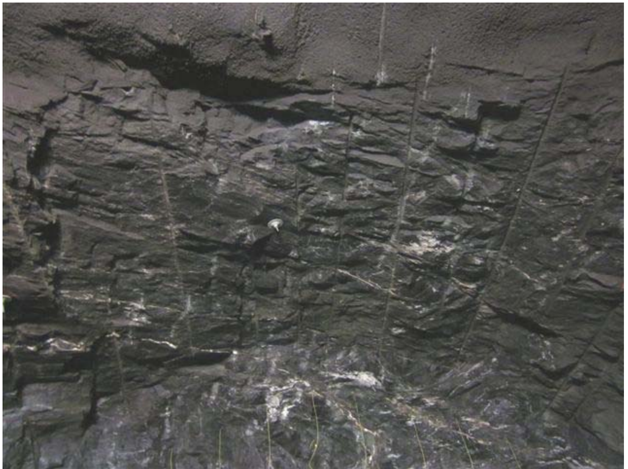
Heng 10.salve ca.profil 893-898,5, litt oppflaking og manglende borpiper til venstre grunnet en foliasjon som faller svakt mot venstre.
