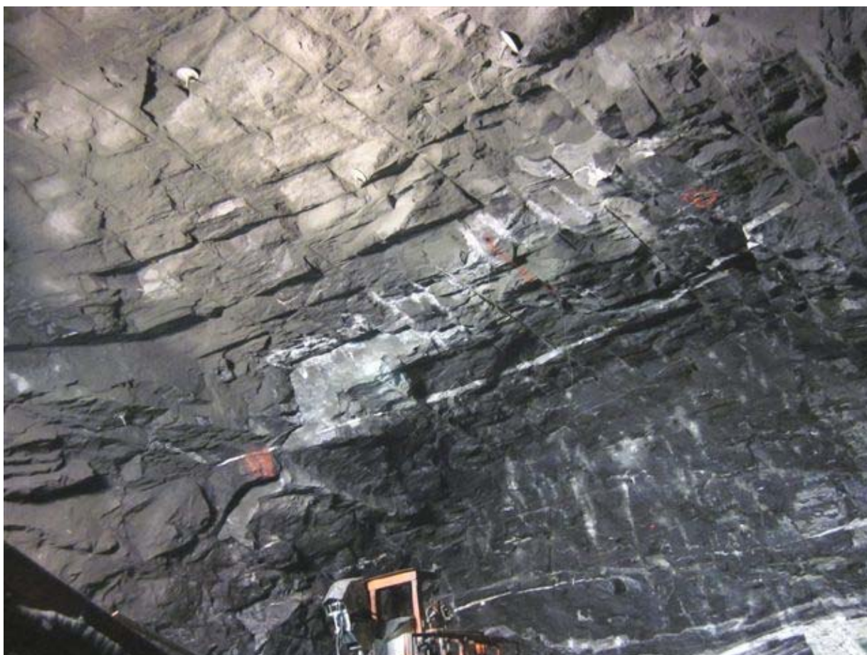
Heng to siste salver, dvs ca.profil 863-73. Foliasjonen er tydelig, med omtrent 35^\circ fall fra stoff.
