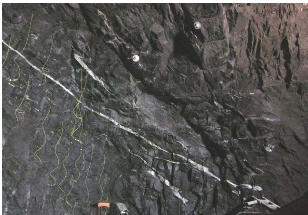
Øvre del høyre side av 4.salve 863-68. Her er også et par utfall etter foliasjonen og steile sprekker. Lite borpiper selv der det ikke er utfall.
