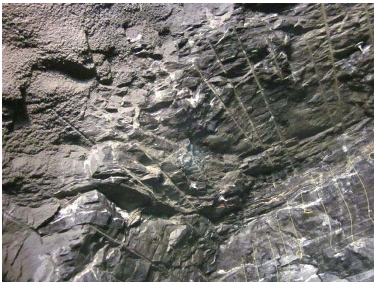
Venstre side 14.salve ca.profil 914,5-919,5. Litt utfall i forbindelse med skifrig sone, ikke alle hull er like parallelle. Gneisffoliasjon med svakt fall mot venstre gir glatte flater uten borpiper i venstre heng.
