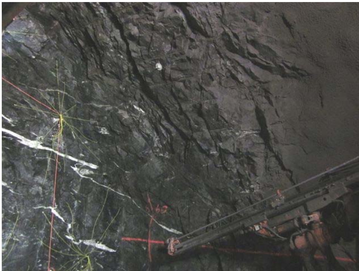
Høyre vegg/vederlag 3.salve, ca.profil 857,5-863.
