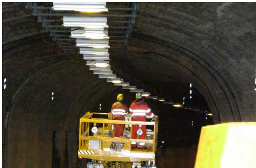
Figur 14 Inspeksjon av E134 Svandalsflonattunnelen (foto Statens vegvesen Sør)
