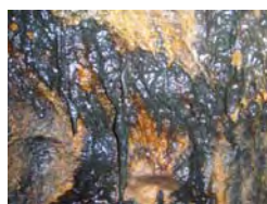
Bakterieangrep på undersjøisk sprøytebetong
