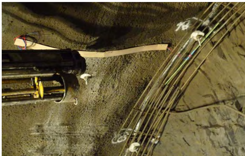
Figur 17 Utstyr for måling tøyninger langs en sikringsbue
