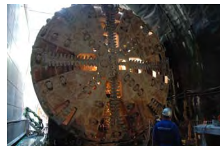
Herrenknecht TBM brukt i boringen av Citytunnelen i Malmö
