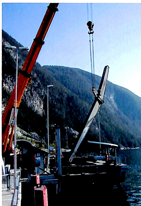
Den ødelagte heisearma tas på land med en 400 tonn/meter mobilkran innleid fra Oslo.
