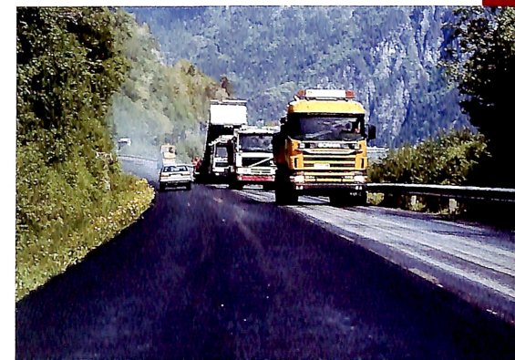
Kilometer for kilometer beveger leggelaget seg framover riksveg 62. Nytt topp dekke, venter bilisten.
