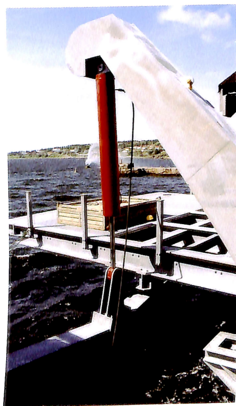
Over: Einar Strand monterer fenderar bak ferjekaibrua for å ta av støyt mot landkaret. God fending er viktig når dei store ferjene legg til kai.
