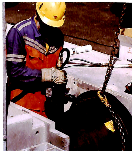
Over: Einar Strand monterer fenderar bak ferjekaibrua for å ta av støyt mot landkaret. God fending er viktig når dei store ferjene legg til kai.
