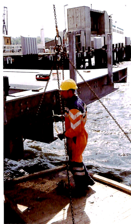
Over: Einar Strand monterer fenderar bak ferjekaibrua for å ta av støyt mot landkaret. God fending er viktig når dei store ferjene legg til kai.
