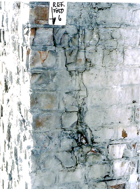
Typisk sprekktype vertikalt i sparesøylene en til to steiner inn. I tillegg vises omfattende kalkutfellinger.
