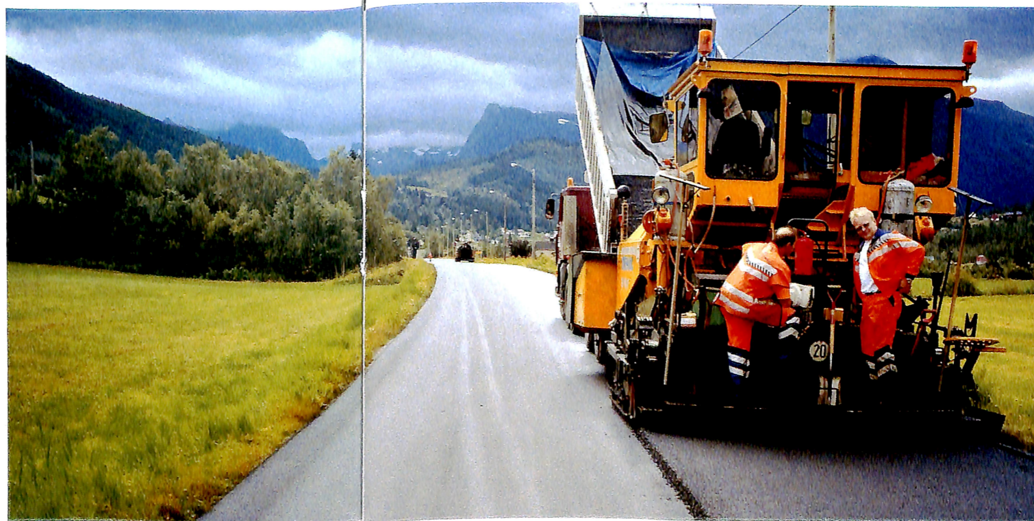
Asfaltleggjelag syd i arbeid på riksveg 655 i Åmdalen.
