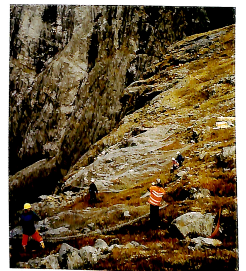
Omlag 5 000 kvadratmeter er sikra med steinsprangnett og 1 000 kvadratmeter er sikra med ubåtnett. Det er og sett opp eit 117 meter langt og 4 meter høgt fanggerde for å hindre nedfall av stein.
