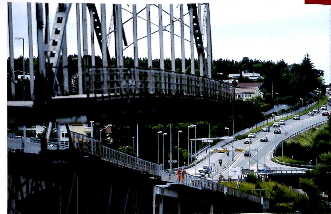
Under: Endeleg kan midtdelen av brua lirkast forsiktig ut frå dei andre konstruksjonane.
