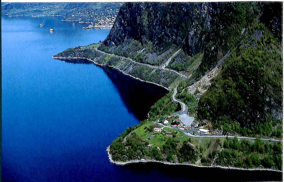
Rotsethorntunnelen gir rassikker veg mellom Volda og Greifsneset. (Foto: Per Tormod Nilsen)
