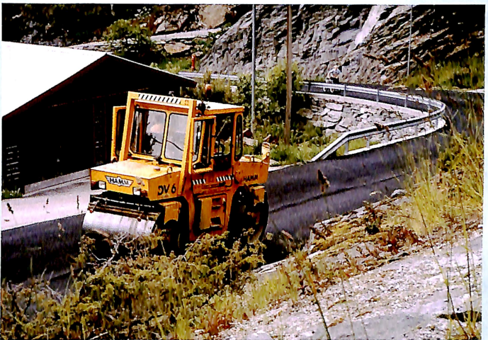
Edmund Norland svingar seg i valsen... Valsing i bratte slynger krev at tunga må haldast beint i munnen, både for å halde seg på vegen og for å få god kvalitet på dekket.
