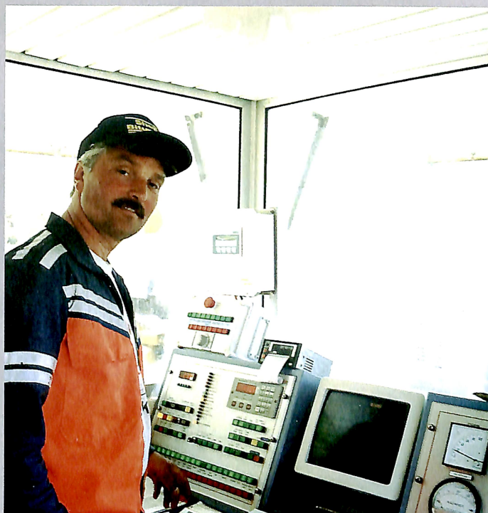
Frå eit lite «kontrolltårn» med utsikt over heile asfaltverket, styrer Roar Liaskar alle funksjonane i anlegget via data.
