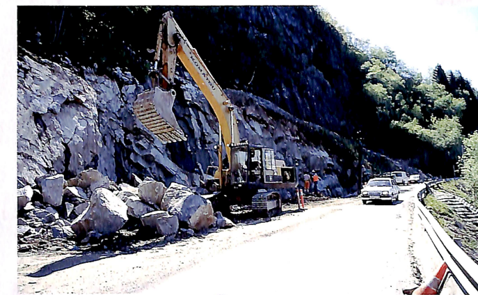
På Dyrkorn er det trangt, og tunnel- og vegarbeidet må gå føre seg tett uti vegen.
