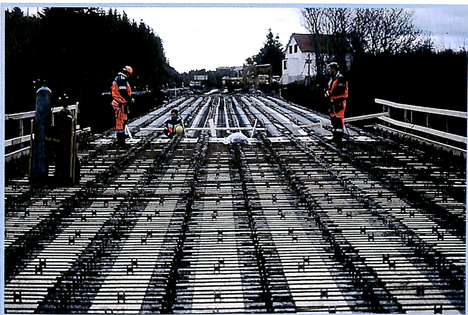
Torbjørn Røsberg, Bjarne Strand og Oddbjørn Bolli i ferd med klargjøring før dekkje vart støypt.
