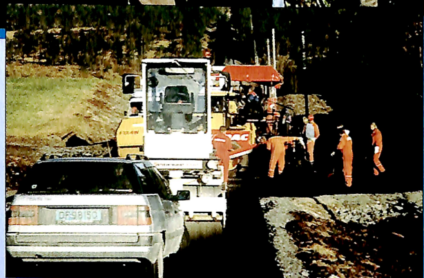
Arbeidet med vegen pågikk til siste slutt.
