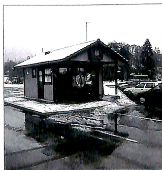
Vekt- og servicestasjonen ligger sentralt like ved riksveg 1/9 på Dragsundet i Skodje kommune.
