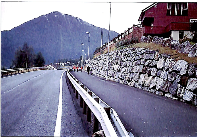
Anlegget Lianes-Skorge bru står fram som en vakker kjede av naturstein tilpasset de naturlige vilkår.
