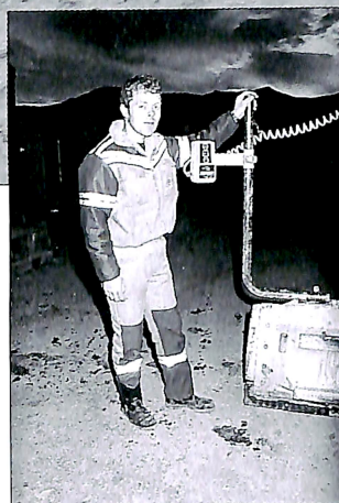
Det er traseren som måler høvelen på veglegemet og som avgjør hvor nøyaktig opprettinga skal bli, og fra kontrollpanelet i
