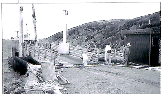
Den nye ferjekaia Dypfest i Sør-Trøndelag var ferdig i oktober. (Foto: Per Korsbrekke)
