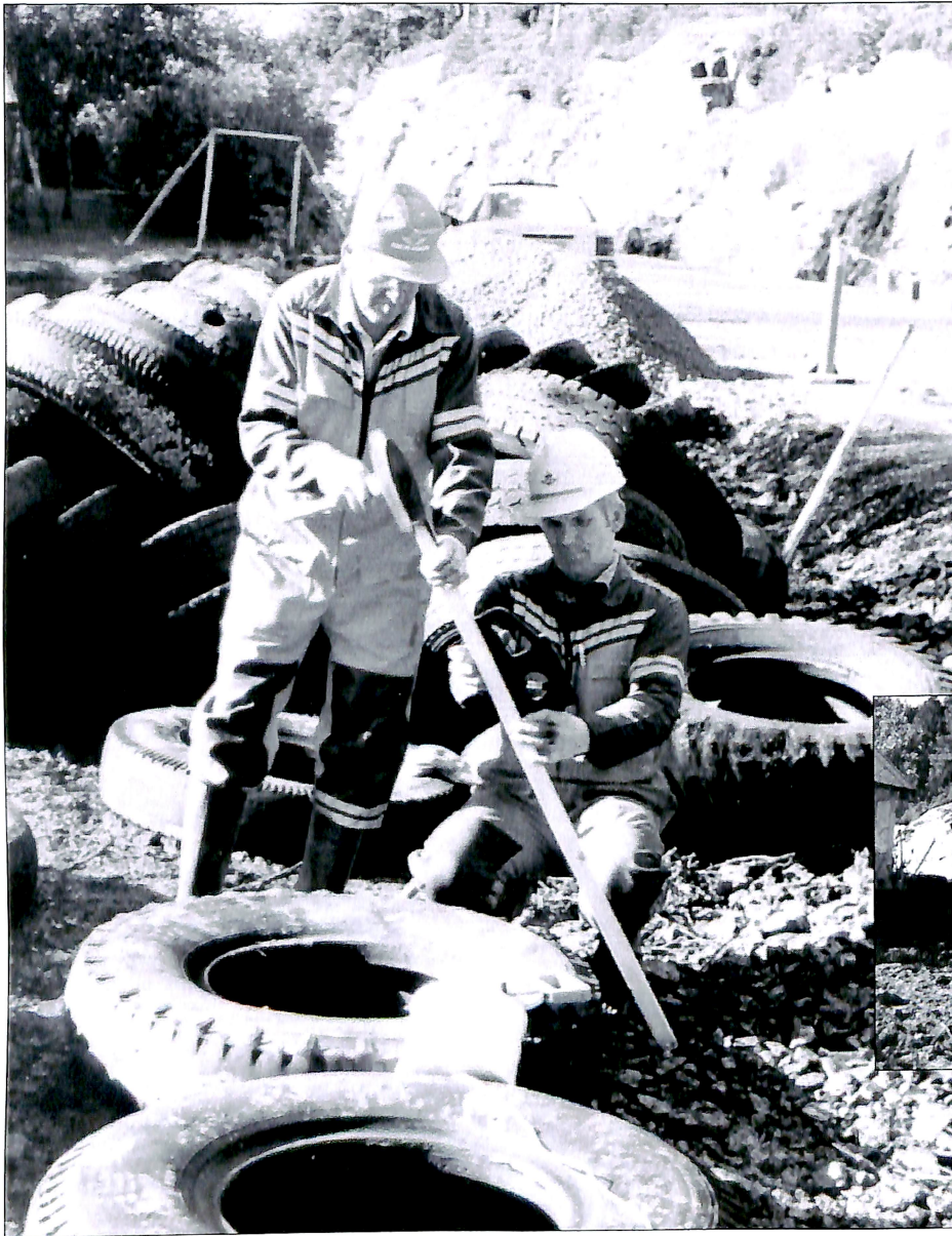
Oddvin Haukeberg (t.v.) og Arnfinn Hanestadhaugen bygger landets første støyvoll av bildekk.
