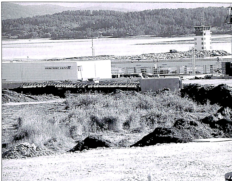
Den nye adkomstvegen til Molde lufthavn var ferdig i oktober.
