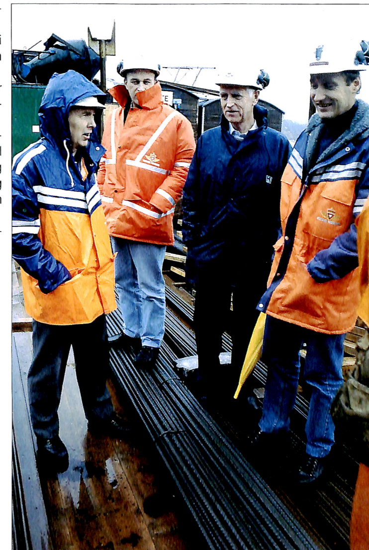
Vegdirektor Olav Sjøteland vitja Aursundprosjektet. Her i samtale med prosjektleder Oddbjørn Pladsen (t.h.), vegsjef Eivind Vollset og overingeniør Svein Solbjørg.
