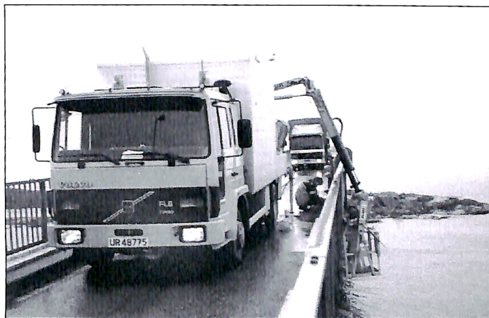
Bruvedlikeholdslaget reparerer rekkverk på Kjønnøybrua.
