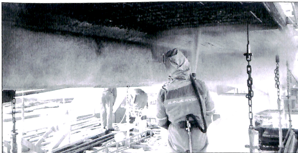
Kjønnøybrua. Tradisjonell reparasjonsmetode.
