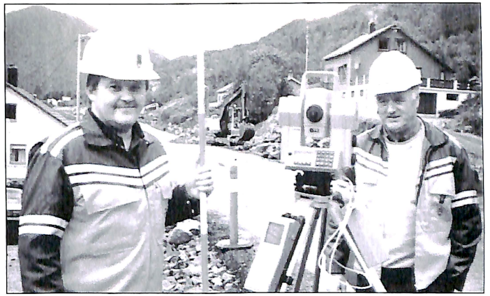
Oppsynsmann Dagfinn Rotevatn og oppsynsmann Jens Monsholm bruker en slik felt-PC på anlegget Lianeset-Skorge bru på riksveg 1.
