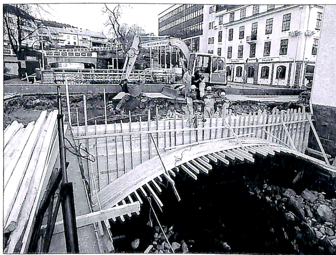
Utbetringsarbeidet på brua over Molde-elva i Strandgata er i godt gjenge
