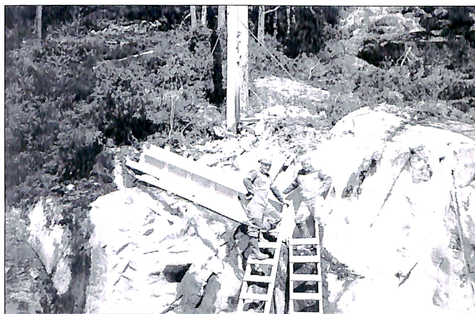
Det er sprengt like inntil ei høgspenmast. Johannes Holten og Ingvar Kvande bygger mur for å sikre masta.
