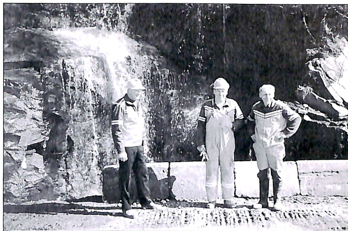
Amund Sylte, Johannes Holten og Ingvar Kvande ved Drivåa. Bekkeløpet er utvida for å hindre utvasking av vegbanen når det er flom.
