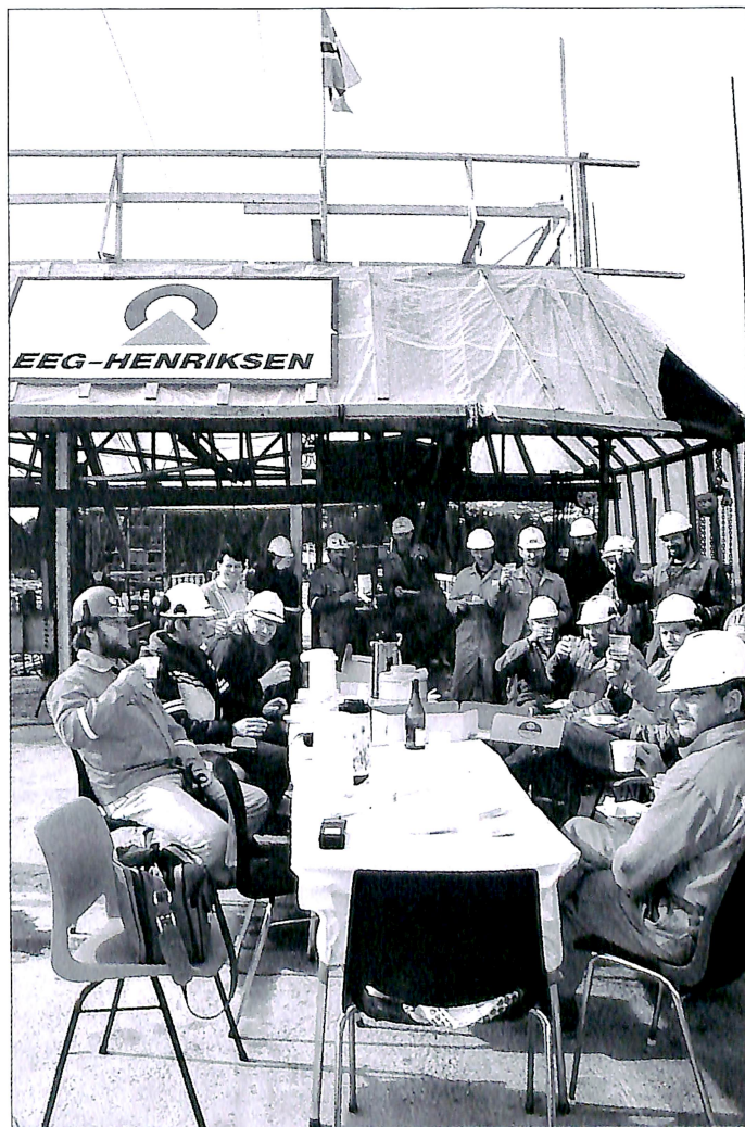
Det ble arrangert stort kranselag på brua. I strålende sol-skinns ble nytraktet kaffe og nybakte kaker satt til livs.
