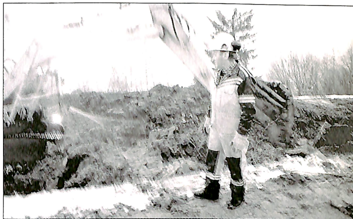
Torsten Skrede, er ein av våre mange trufaste vegmenn, arbeid på Skorge - Lianesparsellen.
