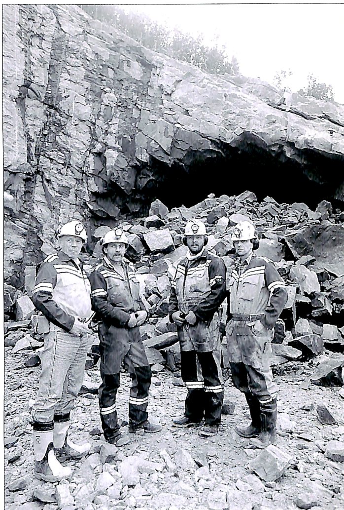
Gjennomslaget for Måndalstunnelen kom 10. september. Øystein Tafjord, Magne Heggem, Arne Løvlid og Jakob Engeseth kan gratulere hverandre med ei ny vellykket salve.
