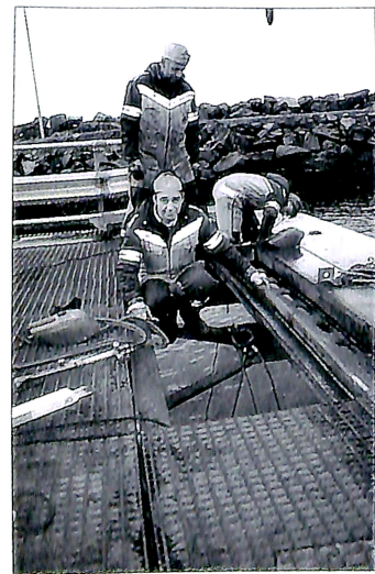
Palmar Orset (bak). Einar Strand og Terje Nordli fra maskinavdelinga på Årø var travelt opptatt med å montere låsekassen på reservebrua.
