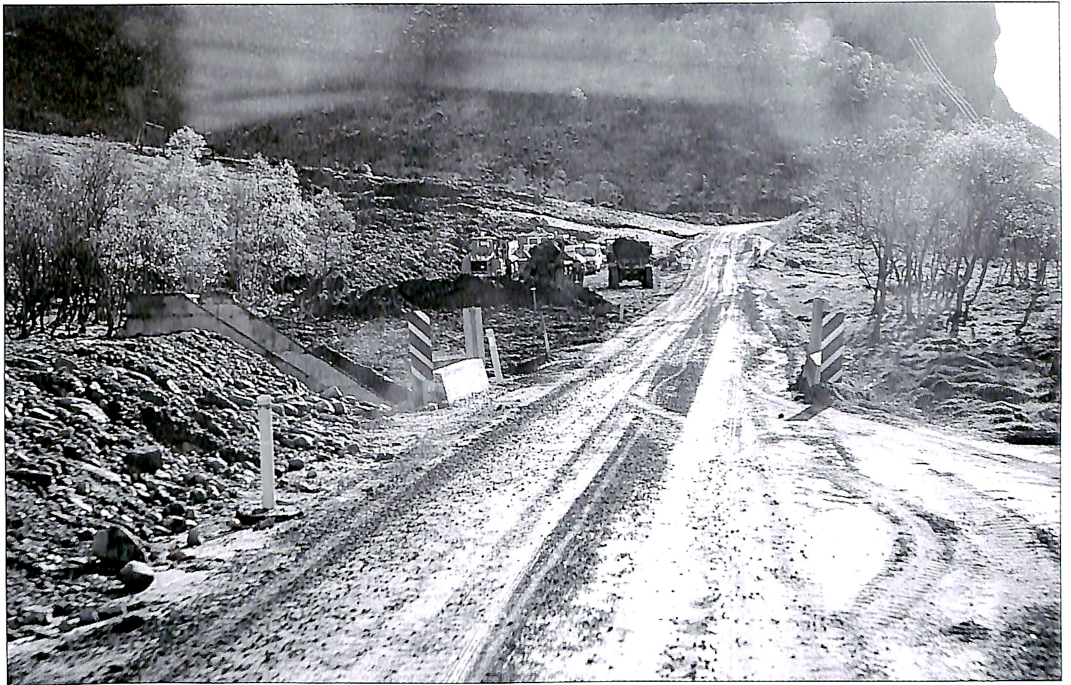
Den siste grusvegparcellen på "THE GOLDEN ROUTE" mellom Eidsdal og Geiranger, får no fast dekke.
