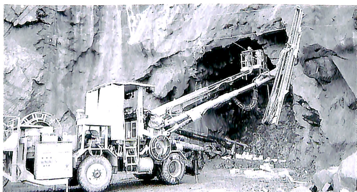
Billedserien over og til venstre: Magne Heggem og Per Pilskog boret 80 hull og la på mellom 300 og 400 kilo dynamitt i den første salva.
