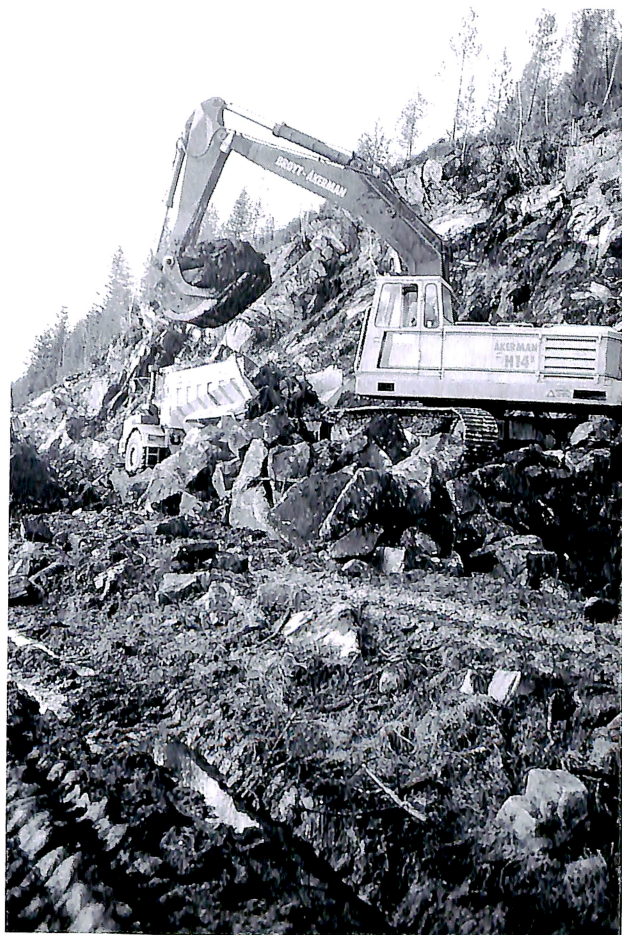
Investeringane til riksveganlegg i 1992 har ei ramme på 260,4 mill. kr.
