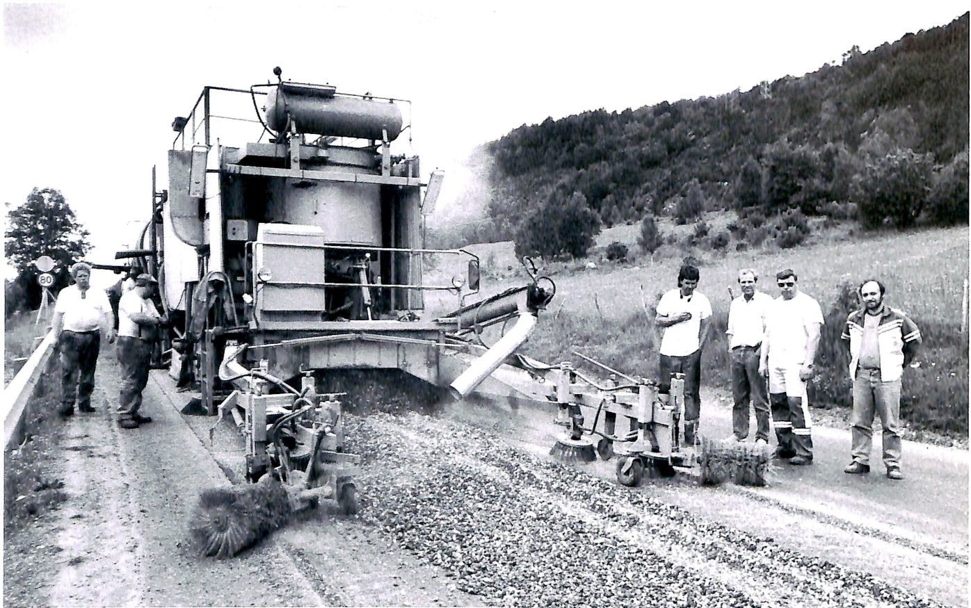
Blandeverket blander den ferdige massen som ligger klar i kjørebanelen, og leverer ferdig reproduisert asfalt til utleggeren på slep bak. Helt til høyre oppsynsmann Gunnar Gjengstø og overing. Roald Småge. (Foto: Viktor Storsveen)
