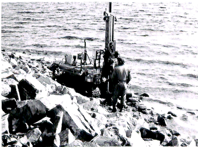
Det har vært boret i grunnen og tatt et utalls prøver. Dette har likevel ikke hindret leirrasene. (Foto: Odd Williamsen)
