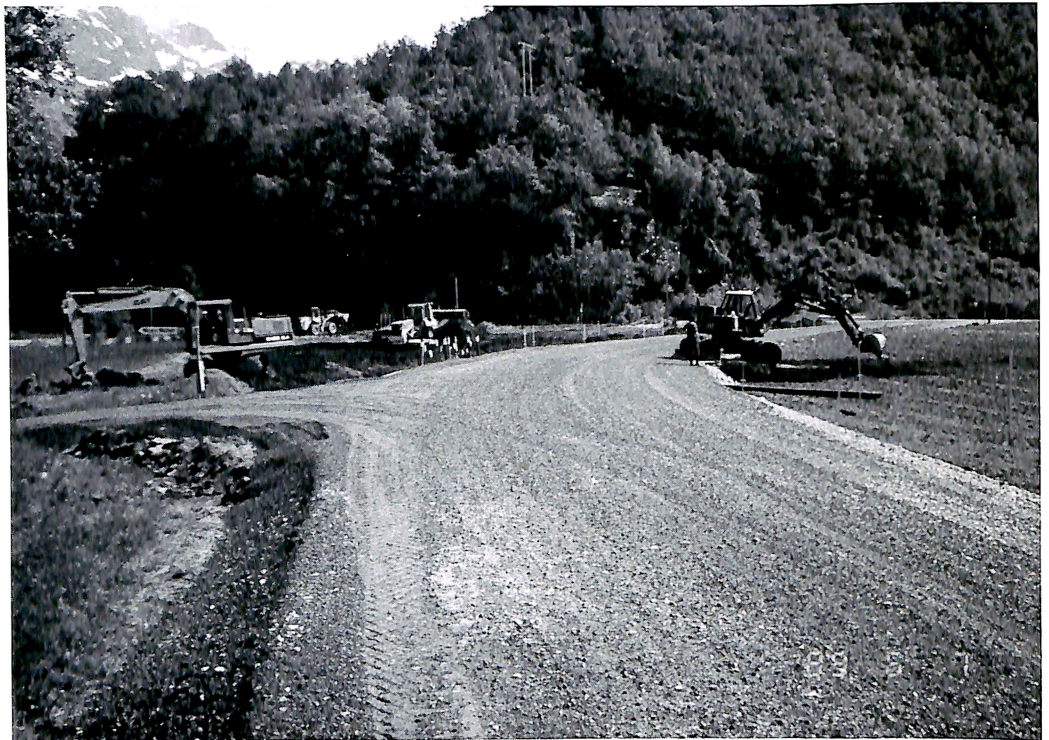
Kursdeltagerne gjorde vegen klar til dekkelegging.
