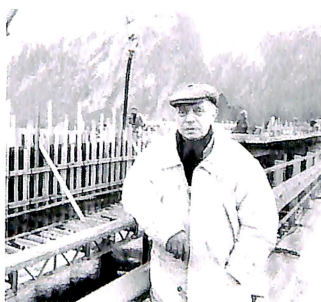
Anleggsleder Jakob Engeseth ved Syltebo bru.
