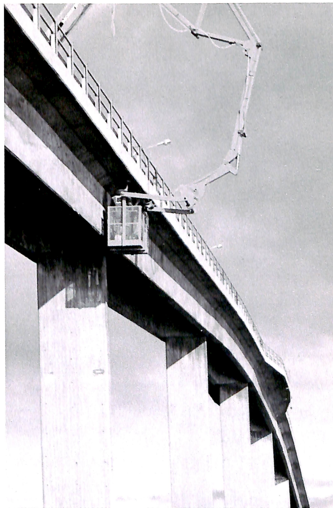
Bruinspeksjon på Verjeskiftet bru på Smøla. Avdelingsingeniør Per Austnes befinner seg i kurven. (Foto: Tore Witso)
