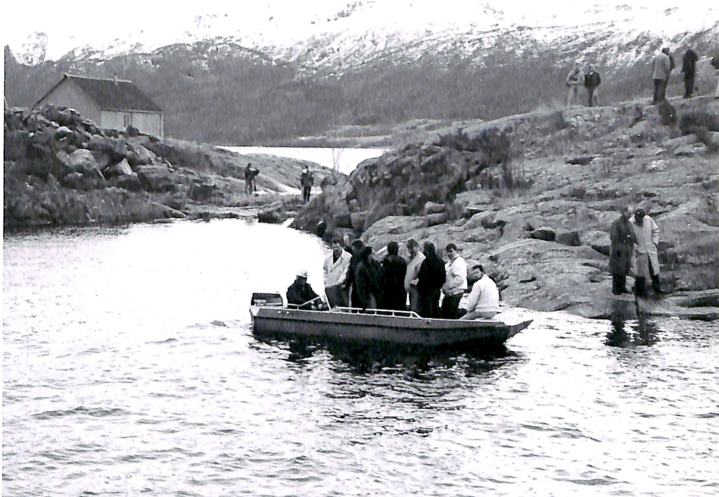
Isak Witsoe og KRIFASTs «Big Buster» måtte tre støttende til ved ilandsettingen på Skjevlingsneset – flytebruas landfeste på Aspøya i Tingvoll. (Foto: Odd Williamsen).
