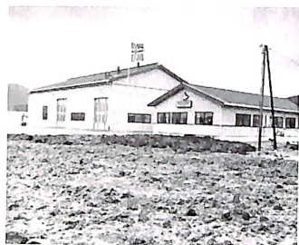
Den nye vegstasjonen tar seg fint ut fra vegen.
