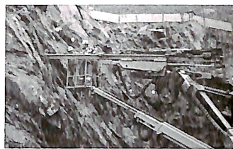
Innsettjing av spiling rundt kontur i Isfjorden. I korga B. Heggset og J. Klungnes.
