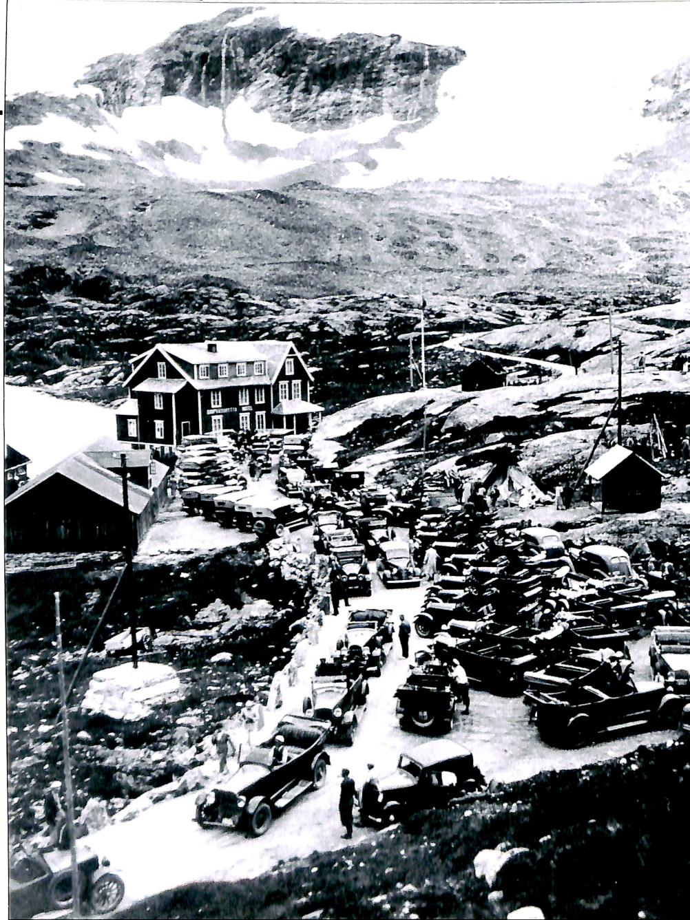
Dette bildet fra Djupvasshytta viser hva for et omfang skysskjøringen hadde. (Foto: Ørjasæter).
