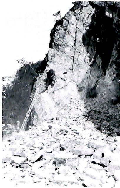
Bjørn Heggset og Ole Røv ligg over borhamrane på storskjæringa ved «Utsikten». Ikkje noko stovegolv akkurat.
