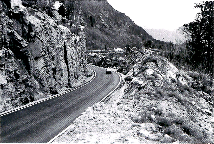
Like sør for Grøttør bru går den nye vegen gjennom ei stor fjellskjæring. Det er her sprengt ut ca. 26 000 ptm 3 .
