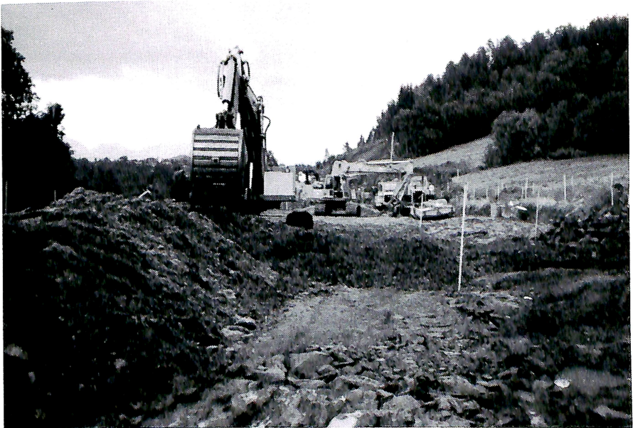
Utlegging av sagflis, avretting og komprimering med beltemaskin. Sagflisa er isolasjonslag og skal hindre frosten i å trenge ned til de telefarlige lag under.
