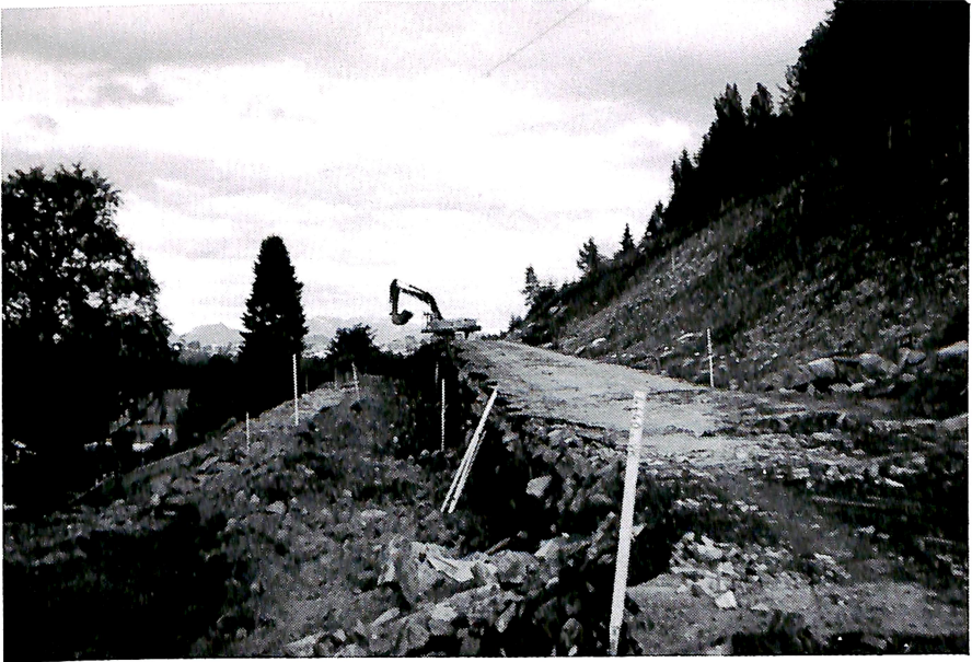
Bakketopper senkes og dårlig masse graves ut.
