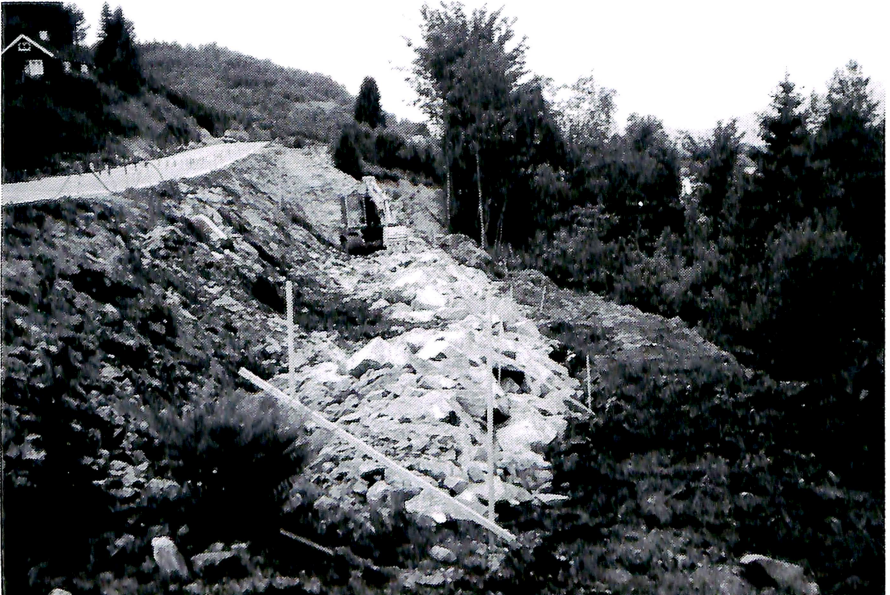
For sikring av fyllingsfot utlegges sprengstein og sikres utløp for alt vatn.
