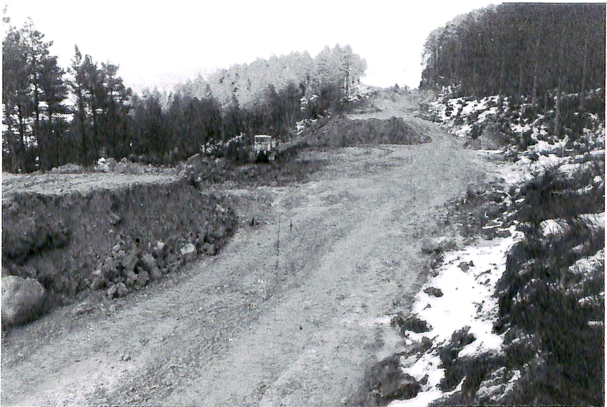
Store lagtjukner og sporvis komprimering fra dumpertrafikken. Fig. 2
