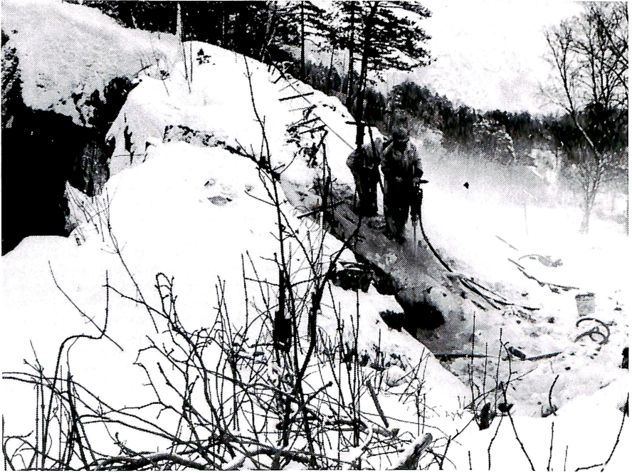
Arbeidet med spregning ved jarnbanetunnelen på Åk er nett starta opp. Sprengningsbas er Jan Berget, på pallan Samuelsen og Brude.
