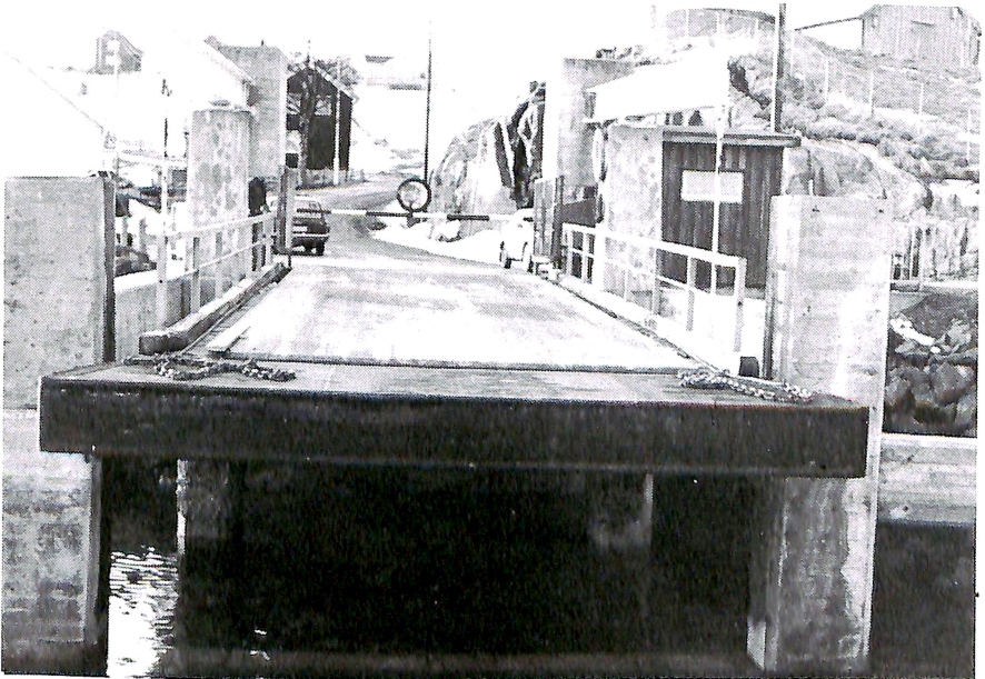
Bildene på denne siden viser Hemnskjel ferjekai. Her er det foretatt reparasjoner på betongkonstruksjonene og fornyet fender- verk.
