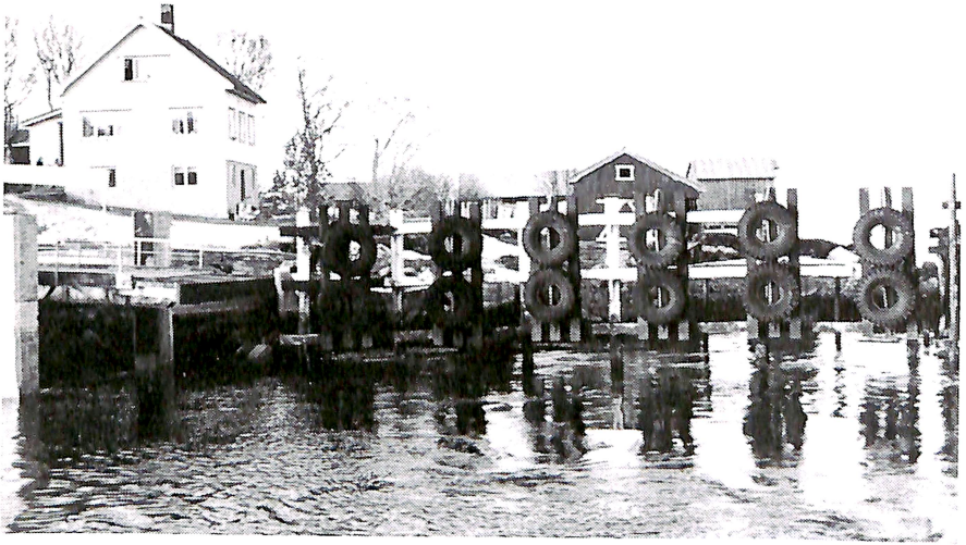
Bildene på denne siden viser Hemnskjel ferjekai. Her er det foretatt reparasjoner på betongkonstruksjonene og fornyet fender- verk.
