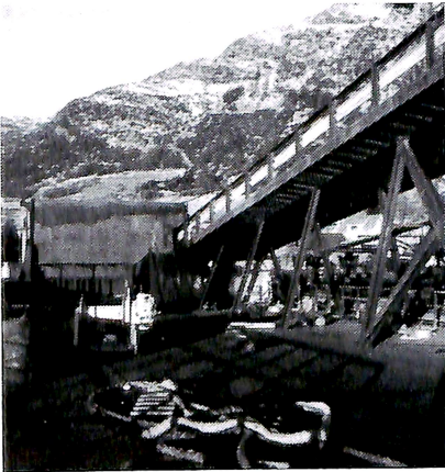
Båtdekk sett forover med oppkjøringsbru.
